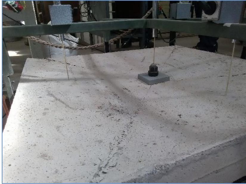
Imagen 20: Aparición de grieta en forma de X, generada por los vértices de la placa de acero al ser traccionada junto con el perno de anclaje
