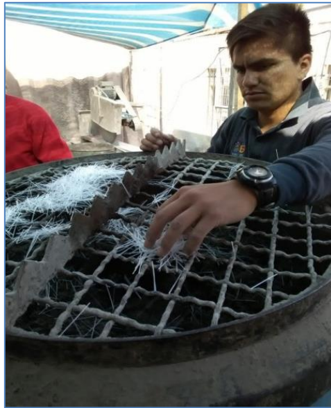
Imagen 6: Colocación de Fibras sintéticas en "betonera", último paso de la preparación del hormigón
