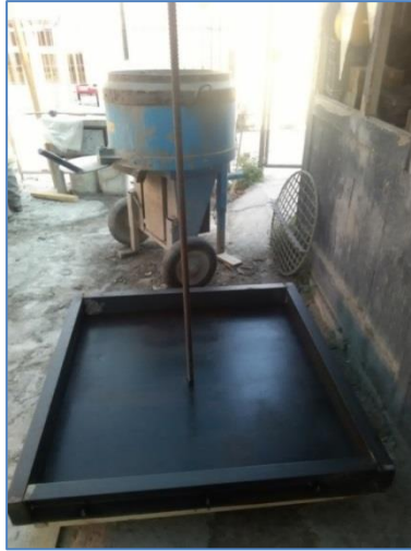
Imagen 8: Moldaje preparado para recibir el hormigón dosificado según "HP1"
