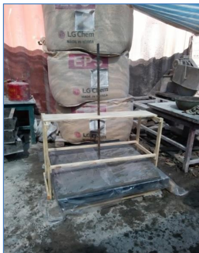
Imagen 10: Panel hormigonado, junto con estructura que mantiene verticalidad de perno de anclaje
