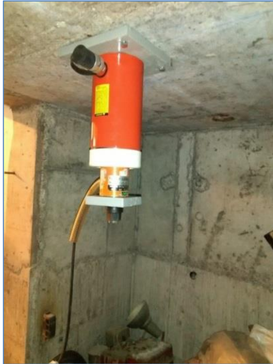
Imagen 22: Gata hidráulica ya probada, instalada y sin aplicar cargas aún
