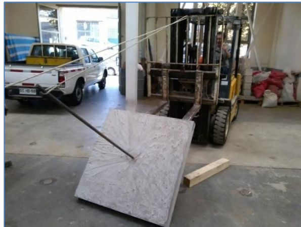
Imagen 12: Sostenimiento de panel para posicionarlo sobre grúa horquilla
