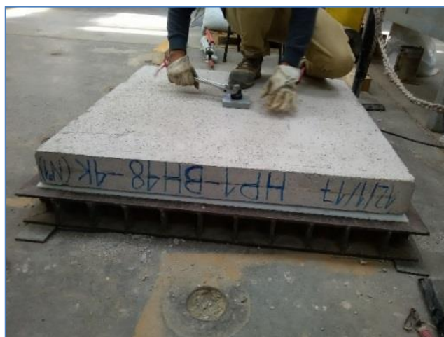
Imagen 16: Una vez ubicado el panel, se procede a atornillar la tuerca que aprieta el perno de anclaje
