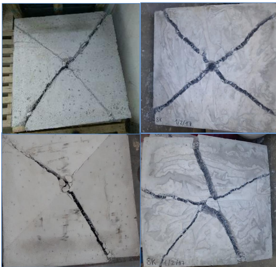
Imagen 26: Patrón de agrietamiento mostrado en paneles con cuantía de fibras sintéticas de 8 kg /m 3 , con evidencia marcada de una cruz (X) más abierta que las anteriores
