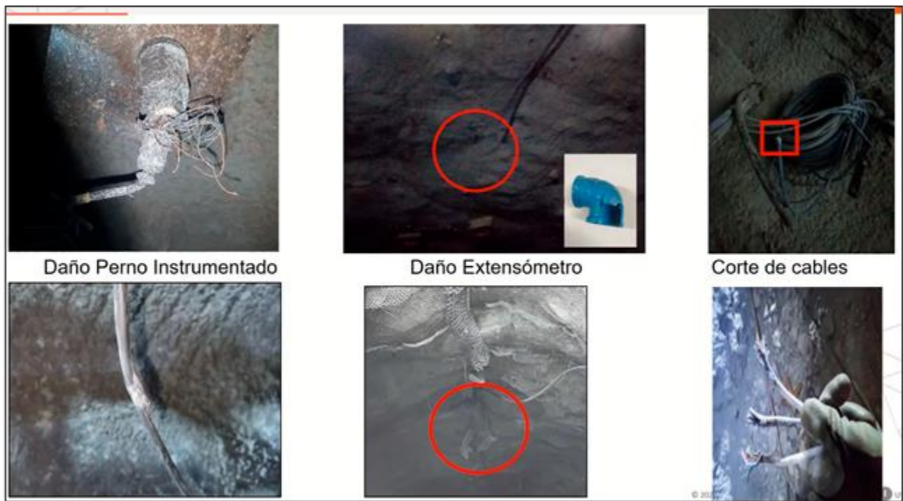
Ilustración 8.1 Efecto de las tronaduras y del trabajo de obras en el sistema de instrumentación.
