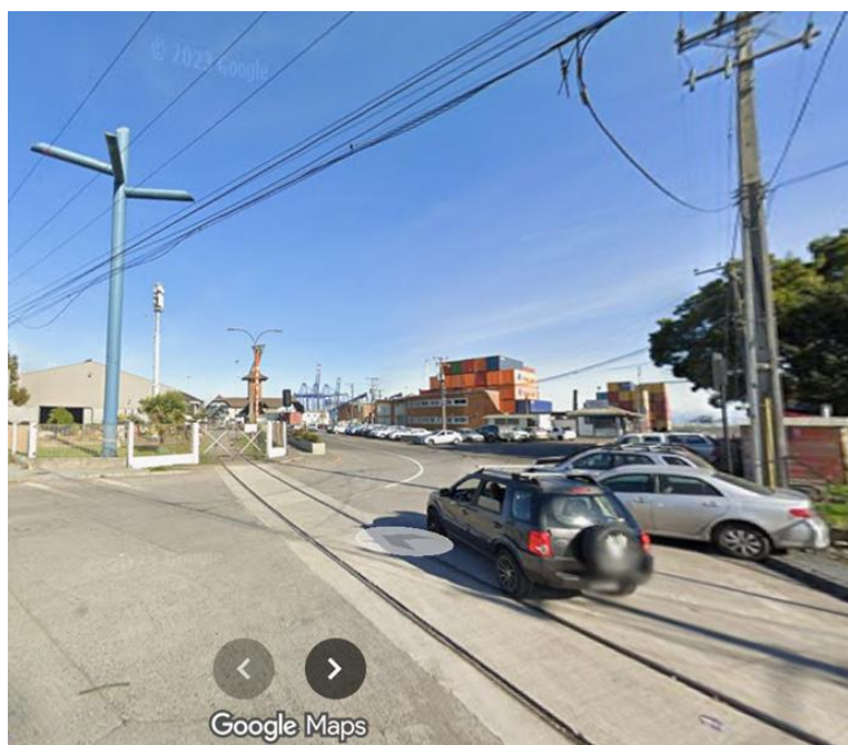
Figura 13. Infraestructura portuaria del Puerto de Coronel. Fuente: Adaptado de [Mapa del Puerto de Coronel], por [37].
