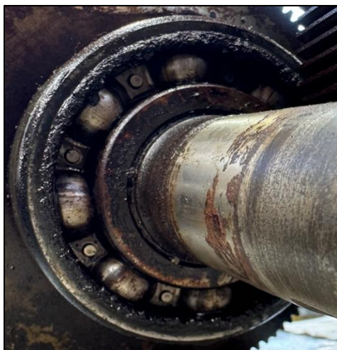
Figura 2-10. Rodamiento con barniz adherido en aro exterior e interior. Fuente: Levantamiento fotográfico en taller de mecánica, Enap Biobío.
