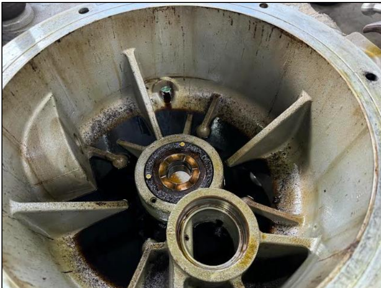
Figura 2-21. Caja multiplicadora con barniz y sedimentos en su interior. Fuente: Levantamiento fotográfico en taller mecánico, Enap Biobío.
