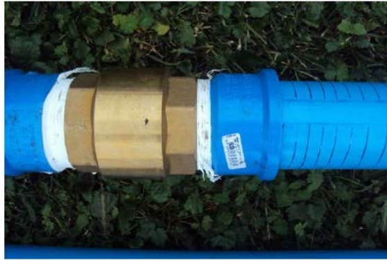
Figura N° 8.6 Conexiones de distinto material.
