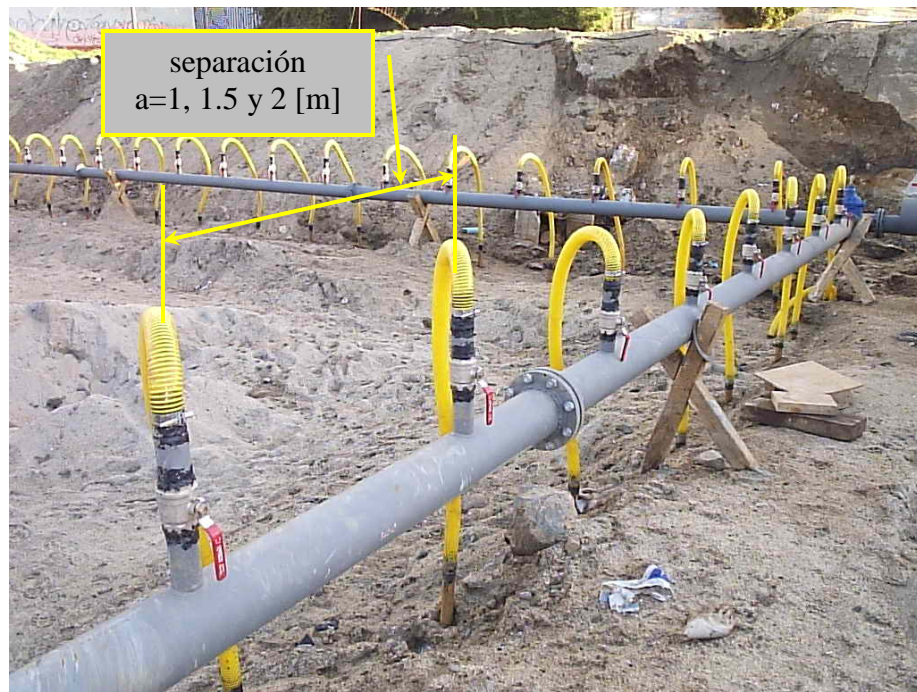
Figura N° 8.5 Separación entre wellpoints.
