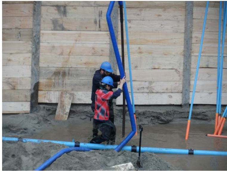
Figura N° 8.3 Perforación del terreno para instalación de wellpoint.
