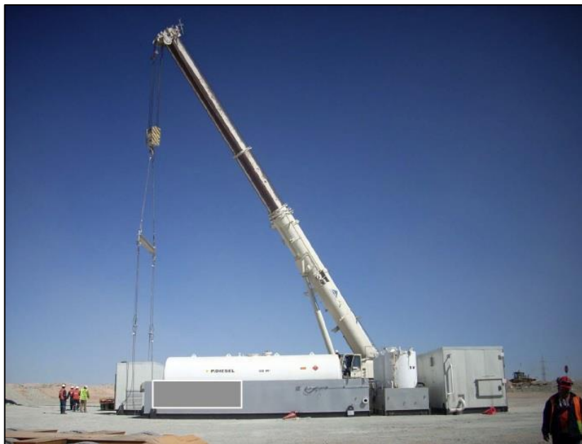
Fig. 13 Pluma de gran capacidad en faena de traslado de tanque de planta Semi-Móvil
