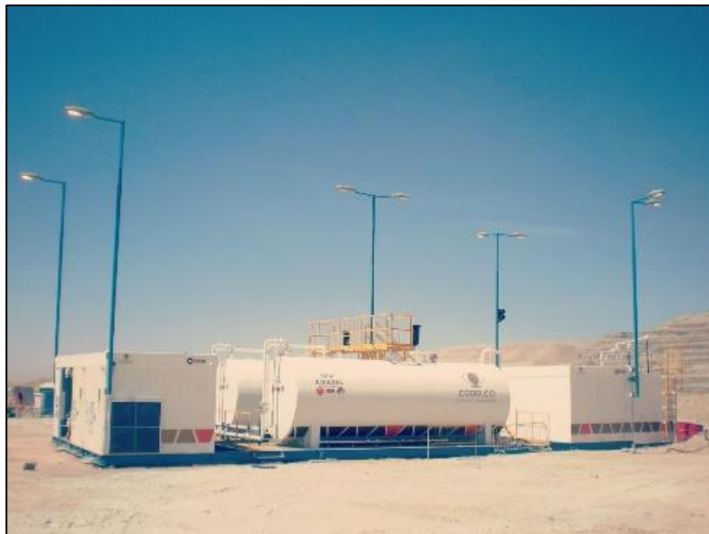
Fig. 19 Planta petrolera Semi Móvil en mina de rajo
