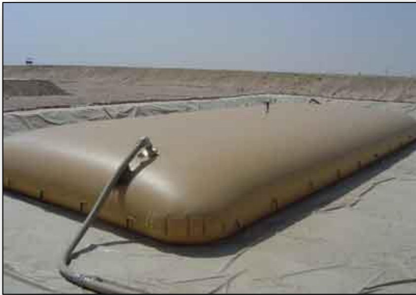
Fig. 3 Tanque de combustible flexible
