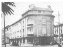
Remodelación del edificio
