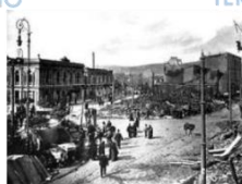
Incendio posterior a terremoto destruye el edificio de 3 pisos
