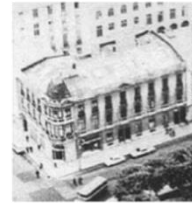
Construcción de obra actual
