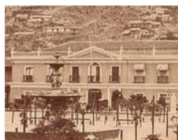
Edificio destinado a viviendas y luego a comercio en la primera planta
