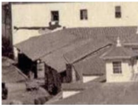
Construcción de 1 piso de adobe
