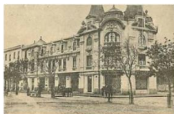
Construcción de un edificio de 2 pisos y mansarda
