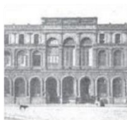
En la esquina de Edwards se construye el cuartel de policía y casa consistorial
