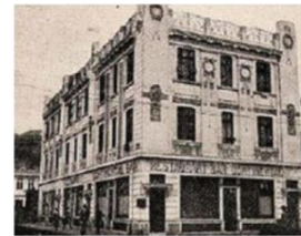
Construcción de obra actual
