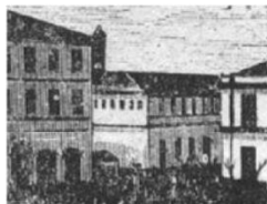
Edificio de 2 pisos con corredor
