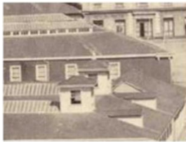
Construcción de 1 piso de adobe
