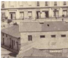
Construcción de adobe
