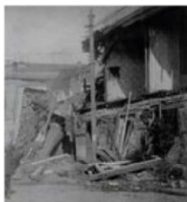
El terremoto derriba el edificio existente
