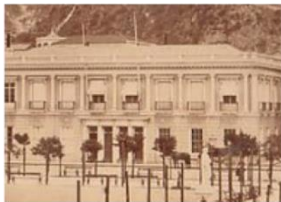
Edificio destinado a viviendas y luego a comercio en la primera planta
