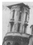
El terremoto produce la caída de la torre
