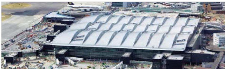
Figura 3.18 Muestra la nueva terminal 2 de Heathrow, que está diseñada bajo estándares BREEAM (ATAG, 2018).
