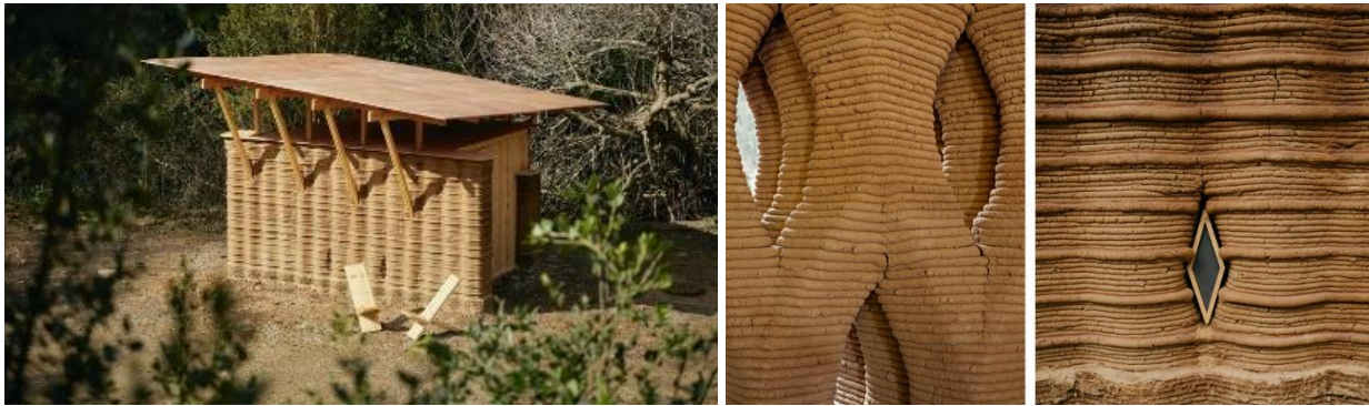
Figura 1. Proyecto vivienda impresa "TOVA" de IAAC. Fuente: IAAC.
