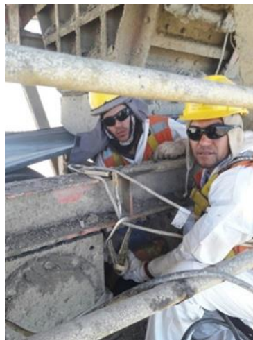
Figura 2-7. Amarre de trabajadores a estructura
