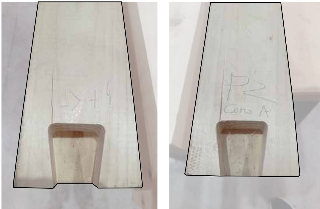
Figura 82. Fotografía intervenida de las rajaduras en el poste más torcido. Elaboración propia
