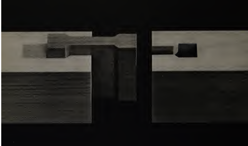
Figura 12. Ejemplo de unión, Fuente: The art of Japanese joinery (Seike, 1977).
