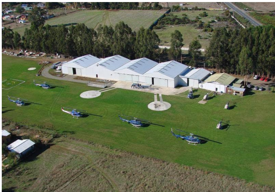
Figura 2.2: Foto aérea de las instalaciones.
