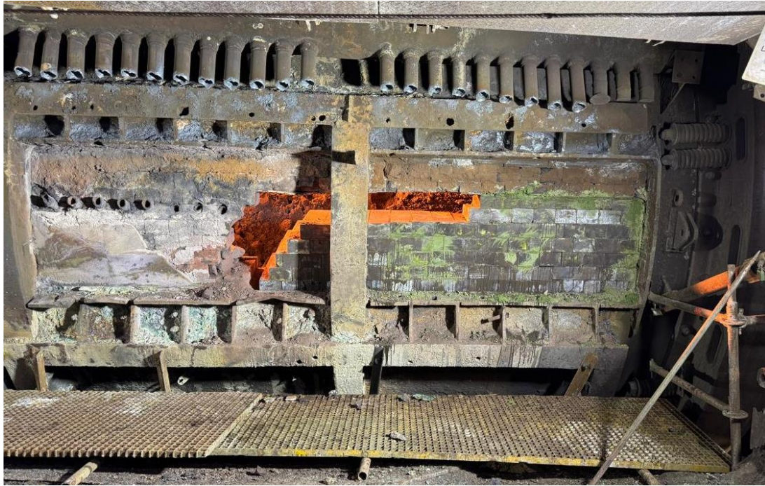
Figura 22 Demolición de zona antigua (central izquierda) y construcción de zona nueva(derecha).
