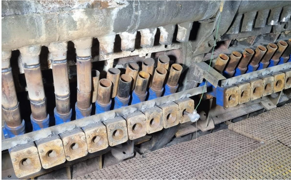
Figura 25 Proceso de soldadura de toberas
