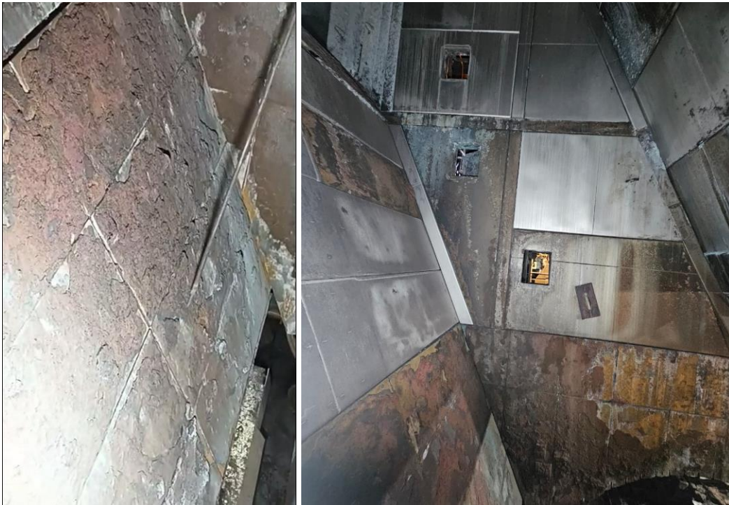
Figura 19 Proceso de limpieza interior campana y posterior campana limpia.
