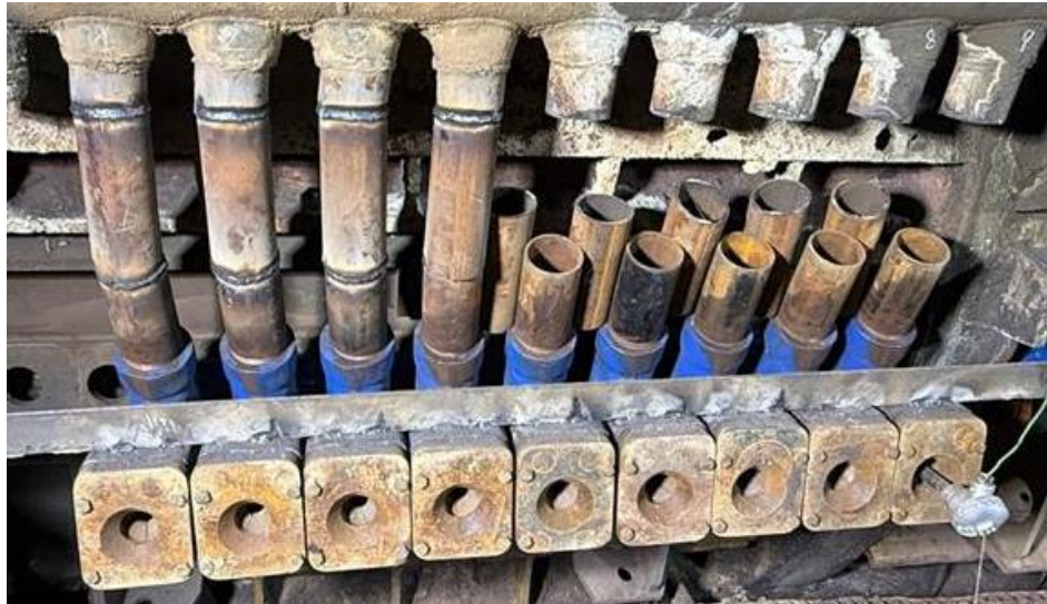
Figura 37 Fabricación de tubos de bajadas de aire y posterior soldadura individual de cada una.
