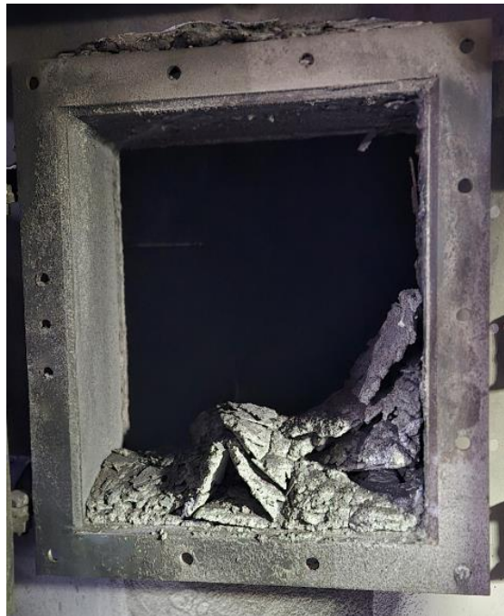
Figura 17 Retiro/instalación de ventanillas de campana.
