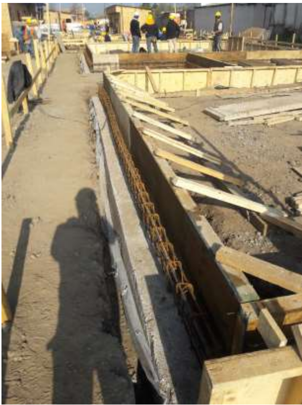
Figura 2.7. moldaje y enfierradura sobrecimiento
