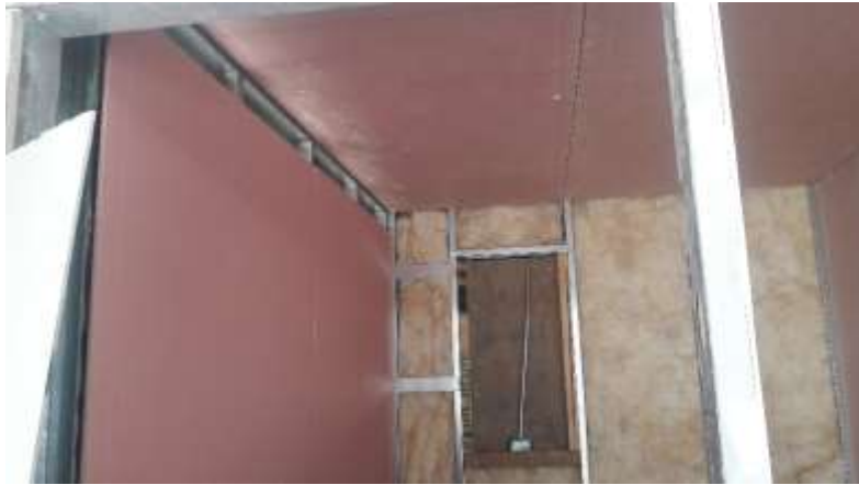
Figura 2.14. Forrado interior con planchas de yeso cartón
