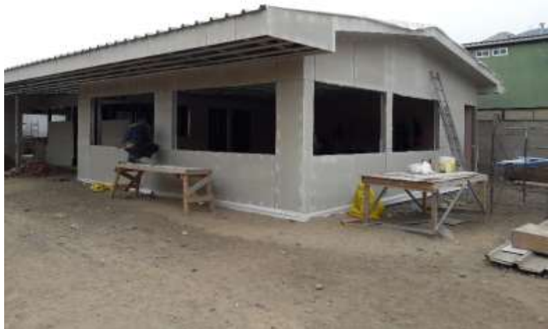
Figura 2.10. Forrado exterior
