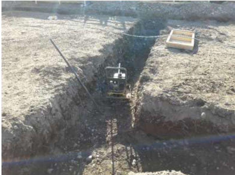
Figura 2.4. Compactadora de 2000 kg. Para cimientos
