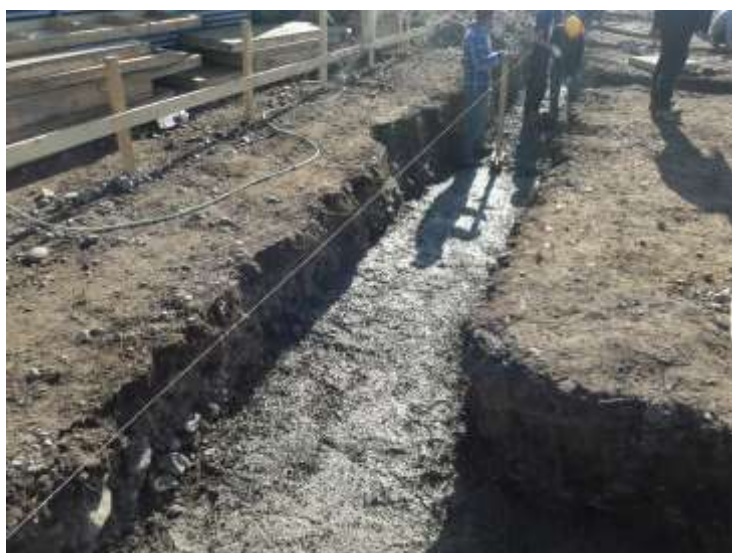
Figura 2.5. nivelación de emplantillado con lienza
