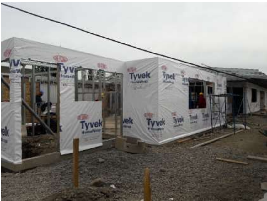
Figura 2.9. forrado de membrana hidrofuga
