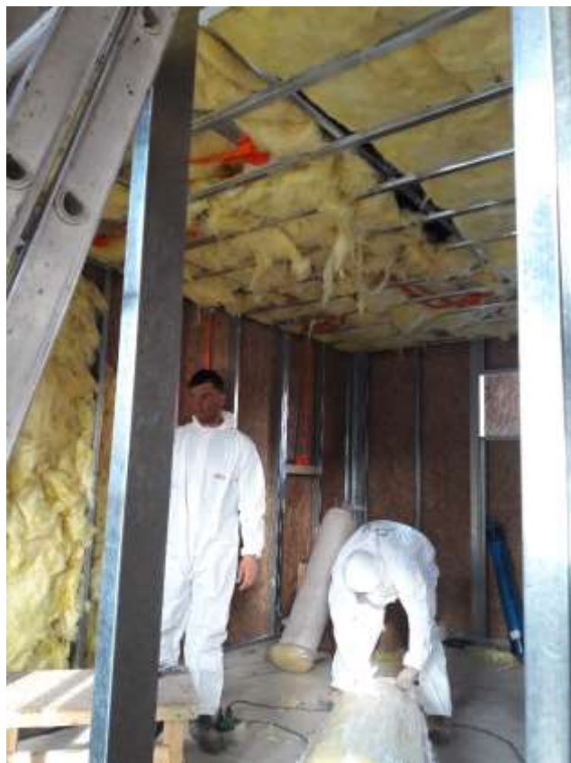
Figura 2.13. Forrado interior de módulos
