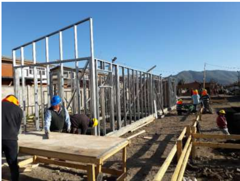
Figura 2.8. Montaje tabiques
