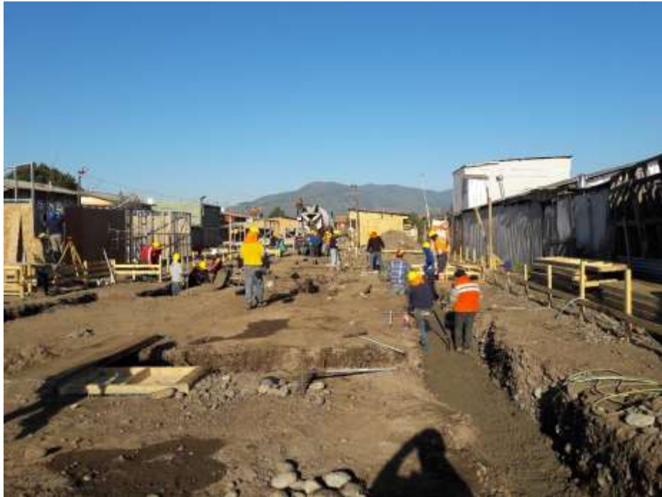
Figura 2.3. Excavación modulo G
