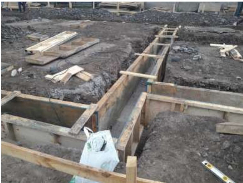
Figura 2.6. Moldaje cimient
