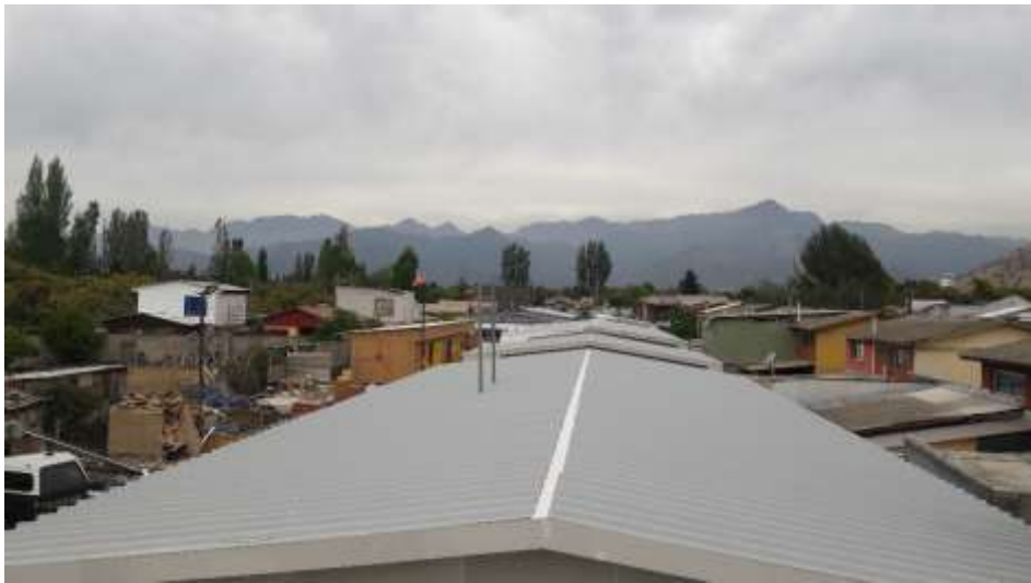
Fuente elaboración propia: Figura 2.16. Techumbres terminadas
