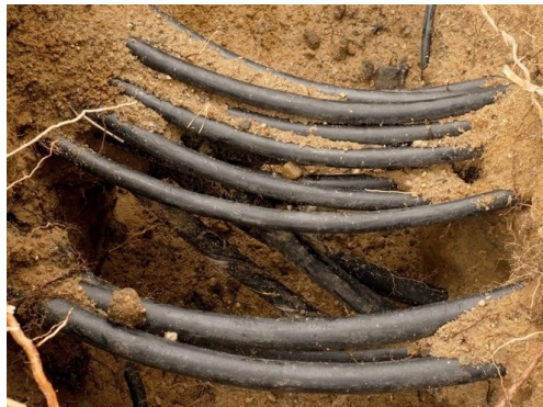
Figura 2.3: Ejemplo de instalación subterránea directamente enterrada. Fuente: [17].
