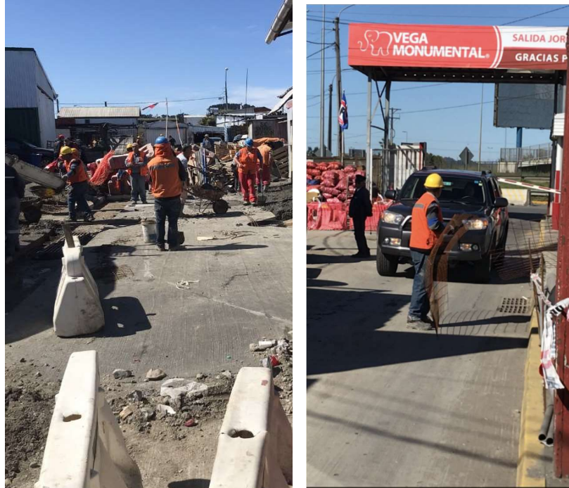
Figura 15 Interrupción de los trabajos debido al tránsito
