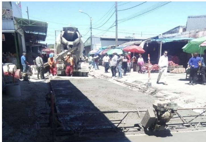
Figura 8 Hormigonado de calle 9, Vega monumental
