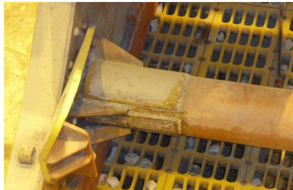
Figura 19: Reparación viga de descanso.
