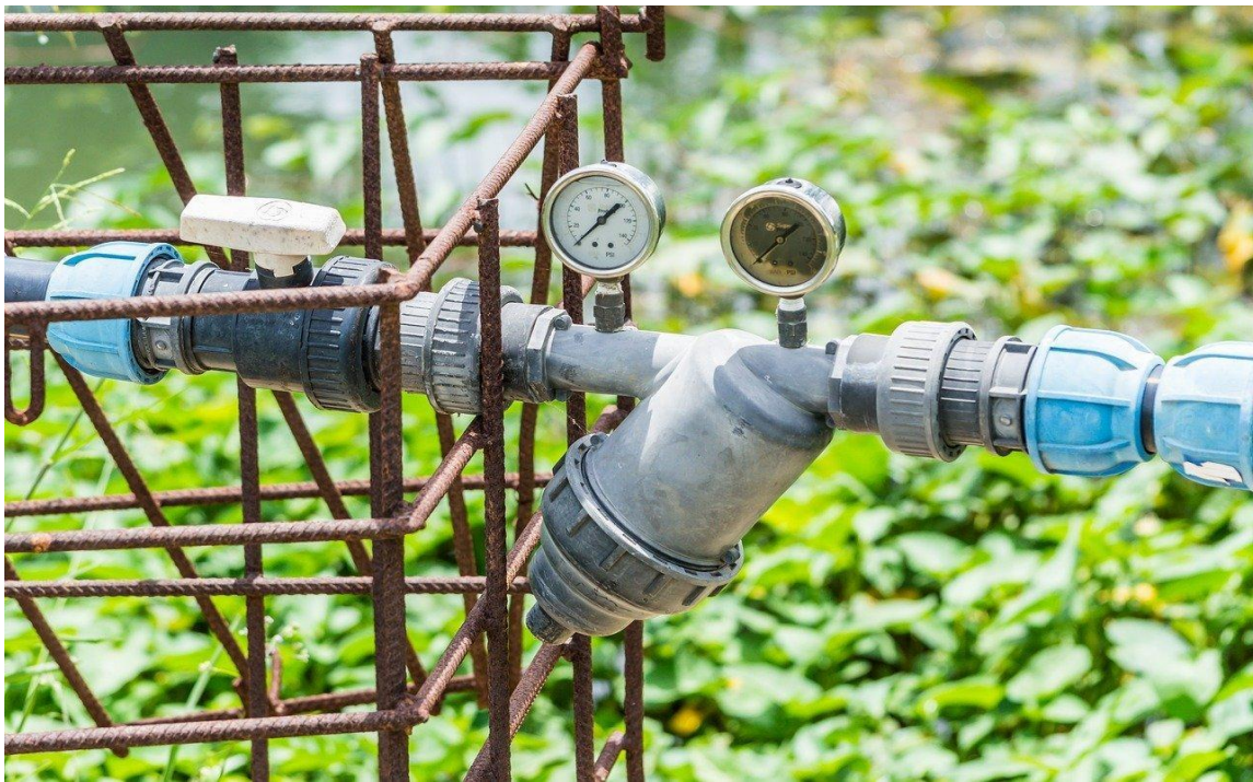
FIGURA 2–7. Evaluación técnica de equipos de bombeo en terreno para levantamiento de información.
