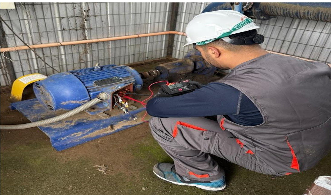
FIGURA 2 – 2. Actividades de mantenimiento realizadas por la empresa Servimant en sistemas de bombeo
