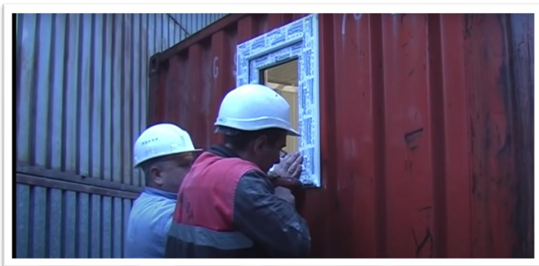
Fuente: https://www.youtube.com/watch?v=oH4fU0awKlg Figura 2-6.- Proceso de instalación de tabiquería y ventanas.
