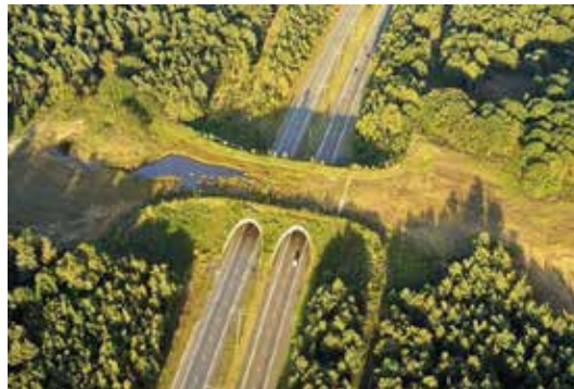
Foto 2, Viaductos para los animales
