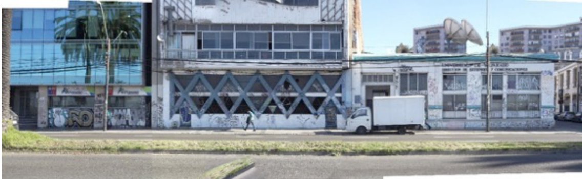
Figura 71. Fachada A, Avenida Errázuriz. Fuente: José Arias
