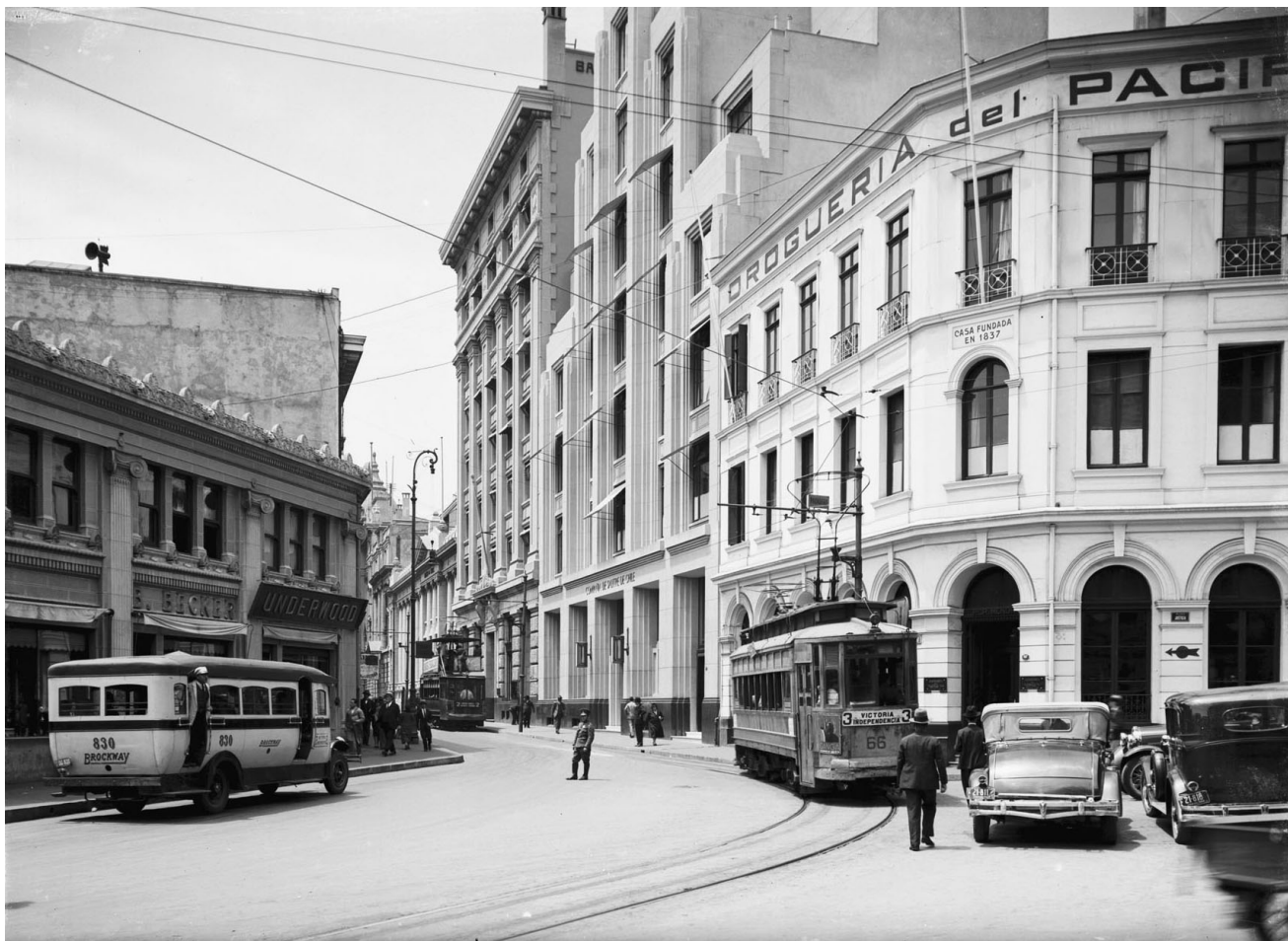
Figura 1. Tranvía y edificios en calle Prat 1930. Fuente: Micrópolis
