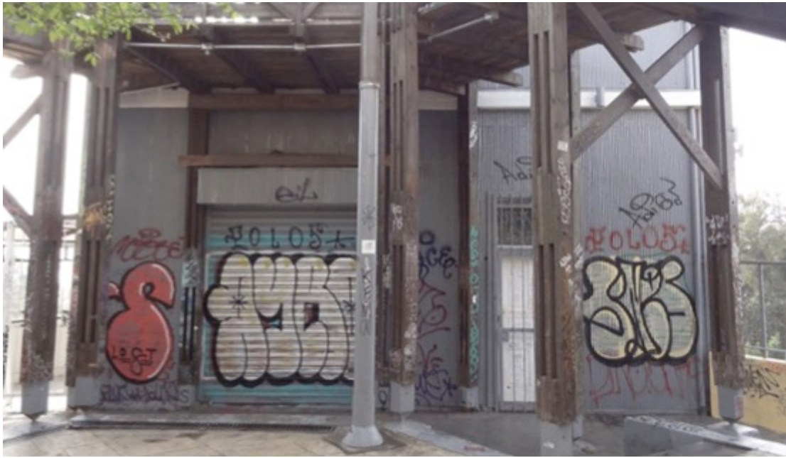
Figura 52. Fachada A, Paseo Dimalow. Fuente: José Arias
