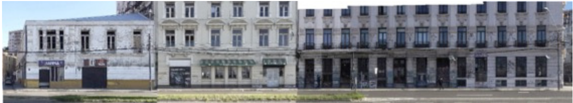
Figura 72. Fachada B, Avenida Errázuriz. Fuente: José Arias
