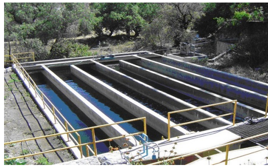
Figura 3.12: Esquema Cámara Contacto
