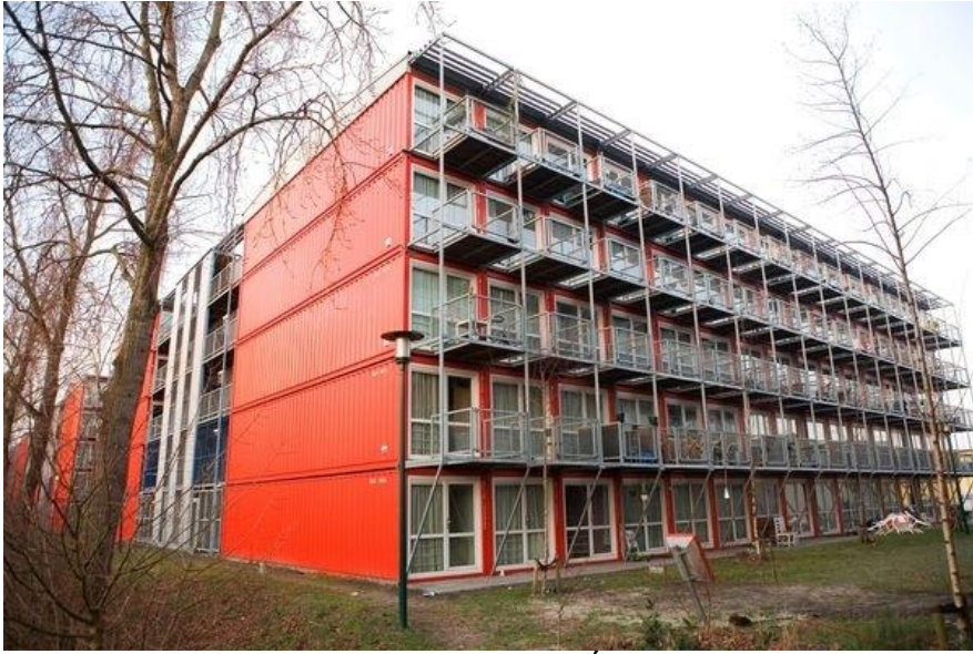
Figura 1-16. Edificio container; Ámsterdam
