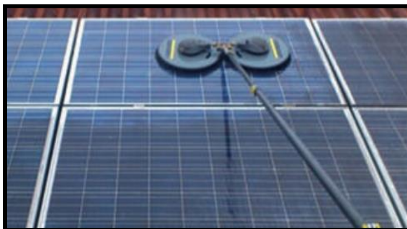
Figura 3-14. Limpieza de un panel solar
