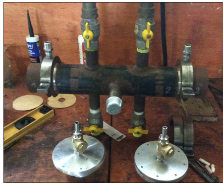
(a) Primera etapa instalación reactor
