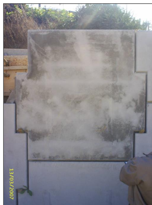
FOTO 31 – Módulo Pref. In Situ Muro Tierra Armada – Pobl. Argentina Alto – Quilpué – Marzo 2007
