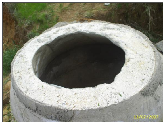
FOTO 34 – Robo Tapas Cámaras – Alcantarillado Desague Sur - Pobl. Argentina Alto – Quilpué – Julio 2007
