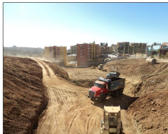
FOTO 12 – Conjunto Reñaca Alto 338 viv. – Const. Valle-Mar S.A. – Viña del Mar – Febrero 2012
