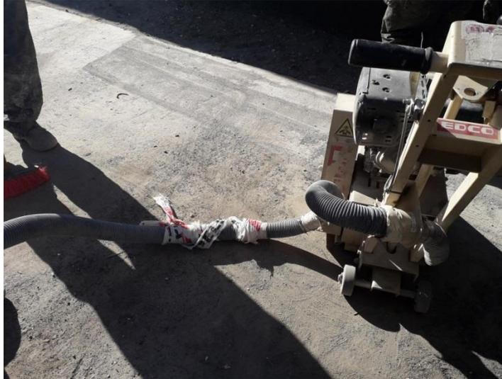
Figura 3-9. Equipo Escarificadora con sistema de extracción localizado con deficiencias e intervenida en su conexión.
