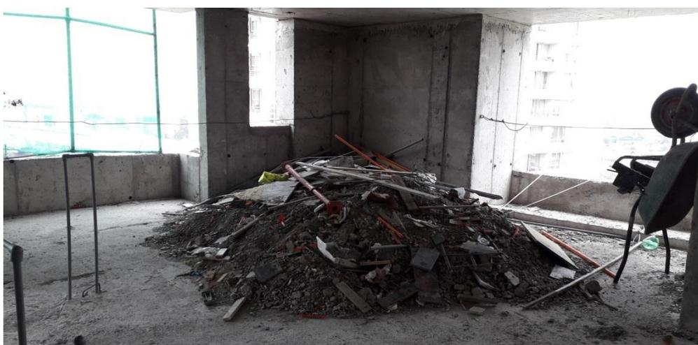
Figura 3-6. Acopio de Escombros sin medidas de control.
