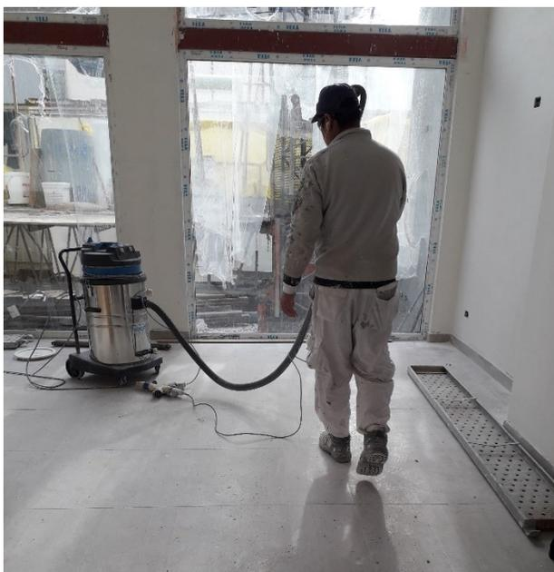
Figura 5-7. Implementación Sistema de extracción localizada pulidora
