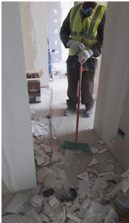
Figura 3-10. Trabajador realizando labores de aseo sin aplicar humectación al escombró acopiado.
