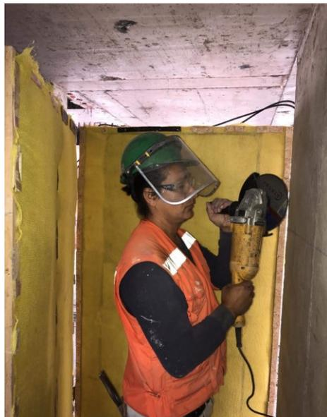
Figura 5-2. Trabajador cortando con esmeril angular sin sistema de extracción localizada ni EPP suficiente.
