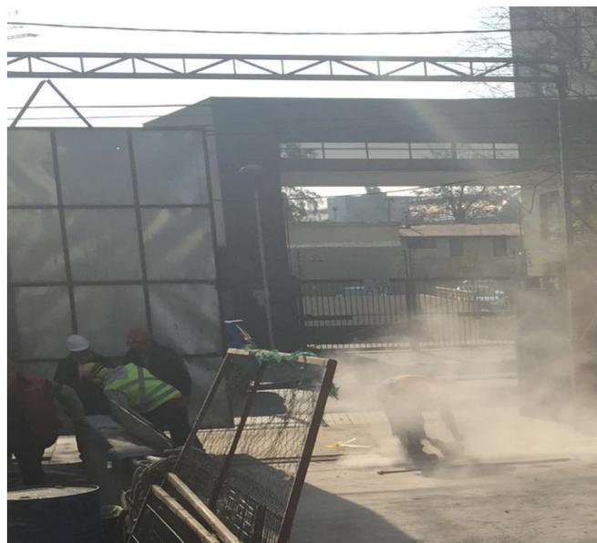
Figura 3-8. Trabajadores utilizando herramienta eléctrica, esmeril angular sin sistemas de extracción localizada.
