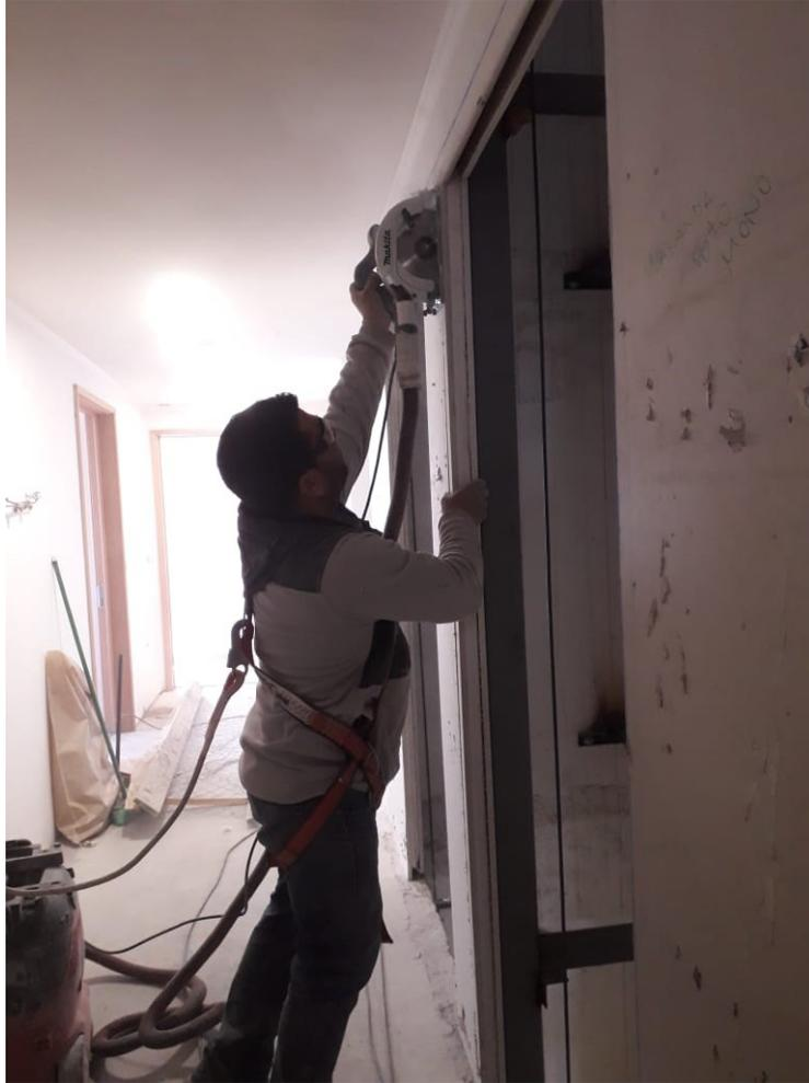
Figura 5-5. Implementación sistema de extracción localizada en sierra circular.
