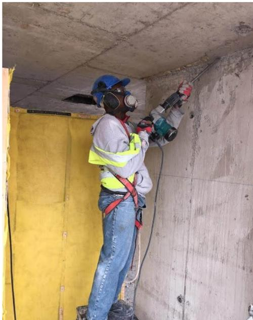
Figura 4-1. Trabajos de un Jornal Picando o puntereo en muros solidos de hormigón.
