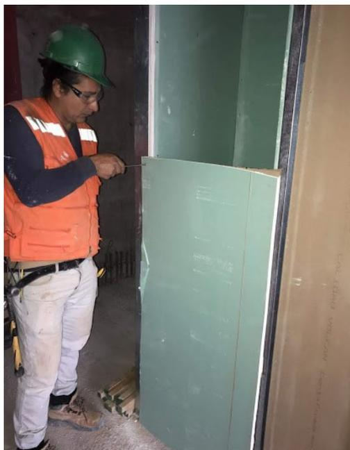
Figura 4-5. Trabajos carpintería de terminaciones con planchas de volcanita.
