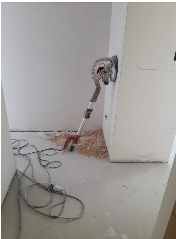
Figura 5-3. Pulidora con sistema de extracción localizada.
