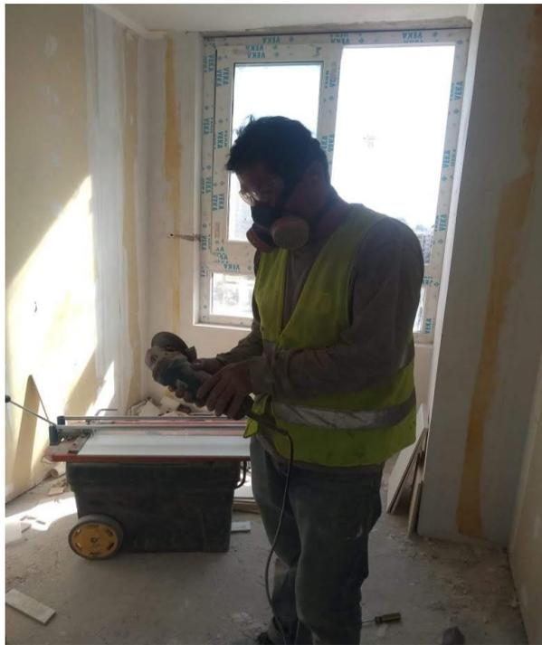
Figura 3-7. Trabajadores utilizando herramienta eléctrica, esmeril angular sin sistemas de extracción localizada.
