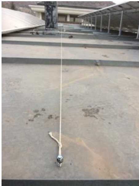
Figura 2 – 19. Trazado para pasillo eléctrico.
