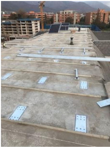
Figura 2 – 25. Secuencia de instalación de panel.
