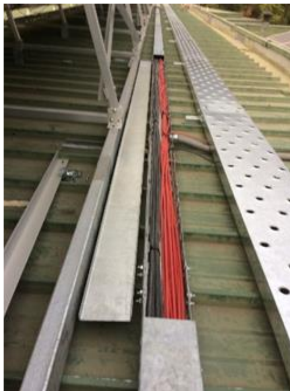
Figura 2 – 9. Canalización terminada.
