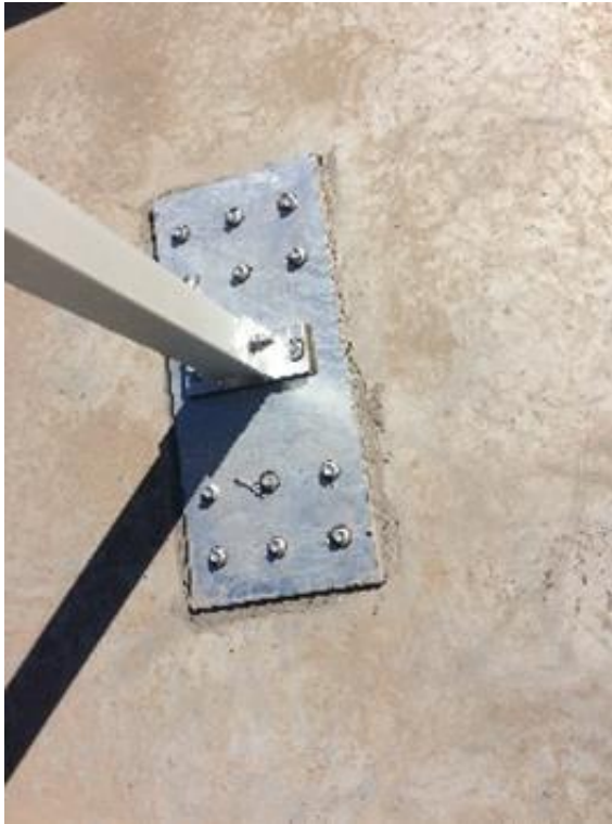
Figura 2 – 20. Anclaje techumbre.
