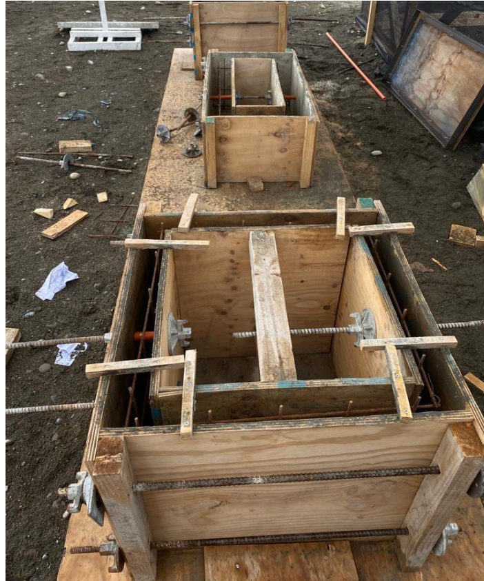
Figura 9. Moldajes para cámaras eléctricas.
