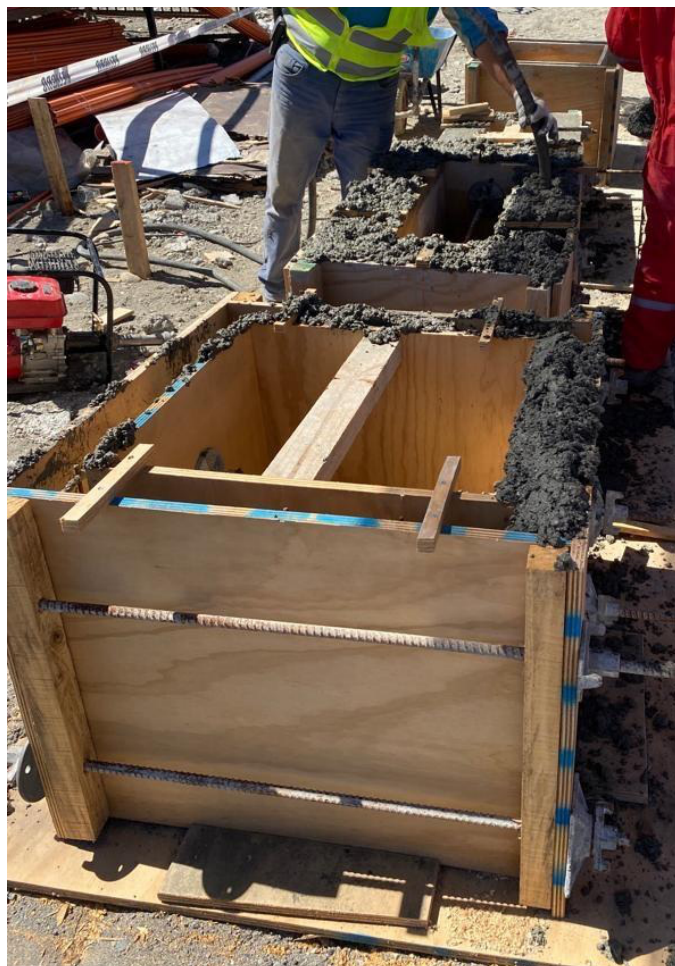
Figura 10. Moldajes para cámaras eléctricas en proceso de hormigonado.
