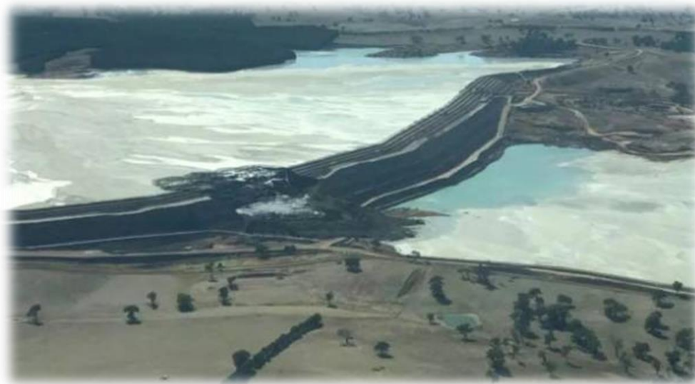
Figura 4-1: Colapso de muro en Depósito de Relaves Mina Cadia, Australia (The Sidney Morning Herald, 2018).
