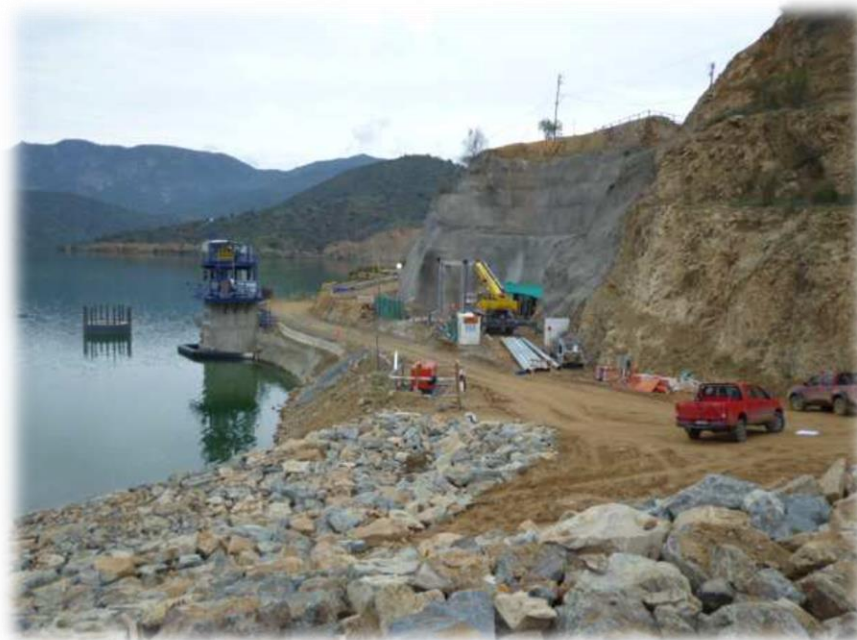
Figura 6-2: Vista del vertedero Morning Glory (DGA, 2011).
