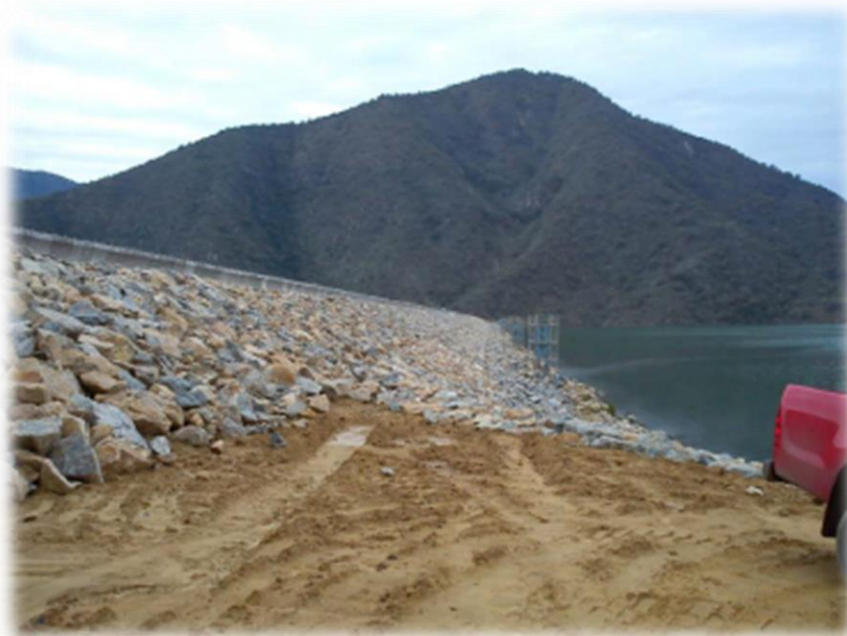
Figura 6-1: Vista talud aguas arriba del muro principal del Depósito de Relaves Carén (DGA, 2011).
