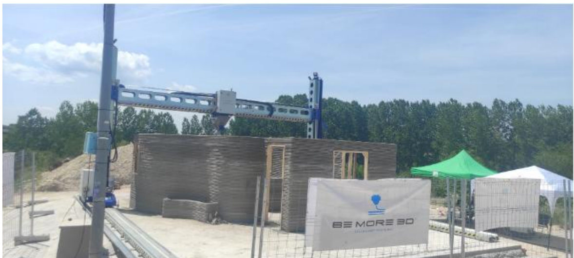
Fig 1: Impresora Industrial UBB: BEM 1 PRO -7500 Be-More.
