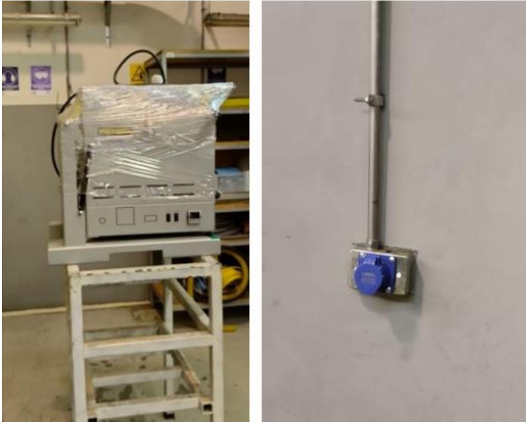
Figura 6-3 Llegada del horno e instalación eléctrica.
