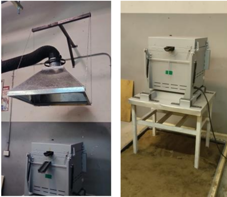
Figura 6-5 Instalación brazo de soporte para campana.
