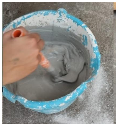
Figura 3-6 Paso 5: revolver mezcla con el agua.
