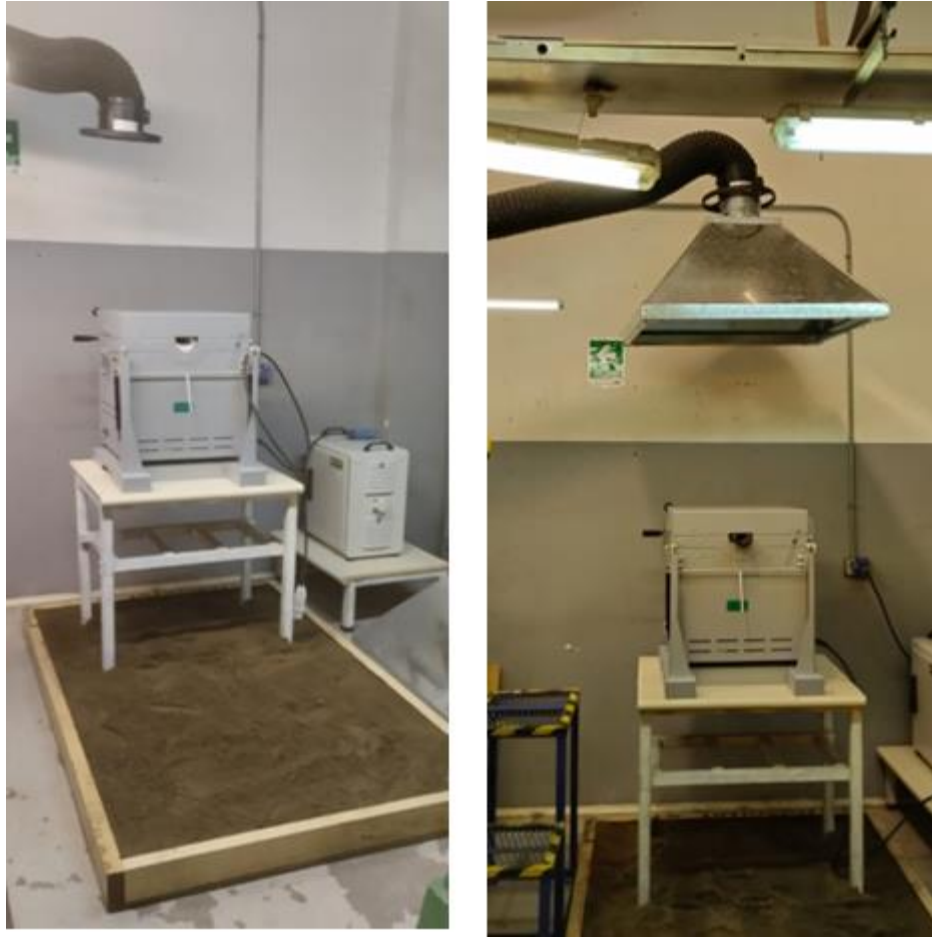
Figura 6-4 Montaje de horno y campana de extracción.
