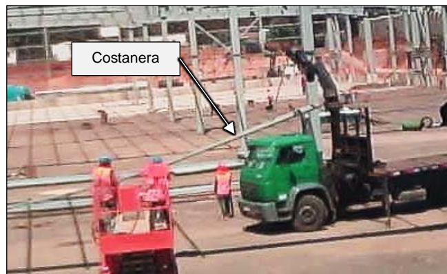
Figura 8.20. Acercamiento de costaneras a zona de trabajo con ayuda de camión pluma
