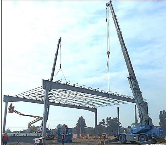
Figura 8.17. Izaje de sección de techo desarrollado en obra en estudio
