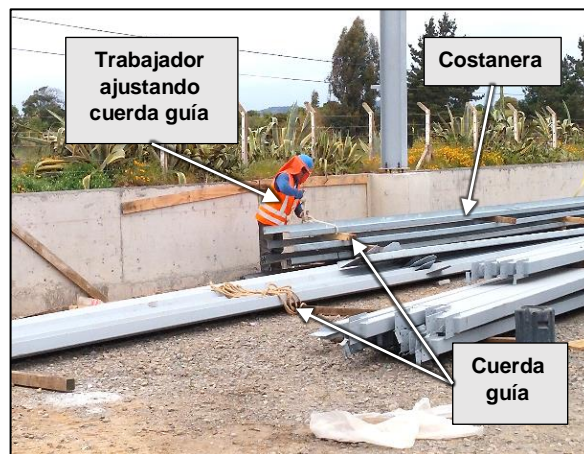
Figura 5.10. Tarea: Instalar cuerda guía
