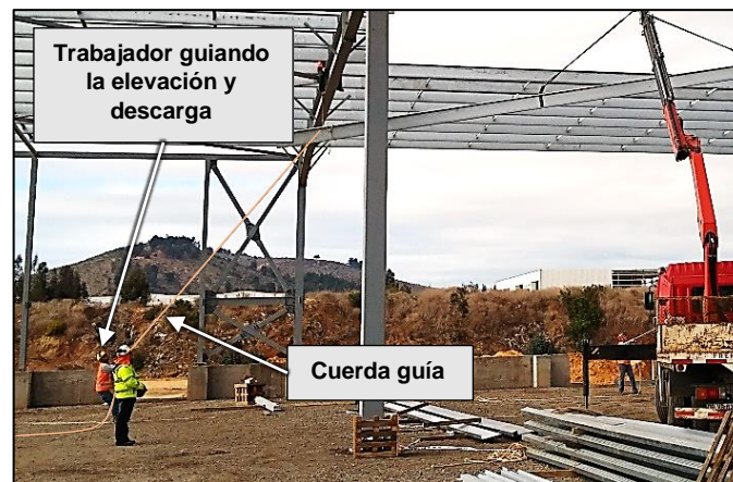
Figura 5.12. Tarea: Guiar elevación y descarga con cuerda guía
