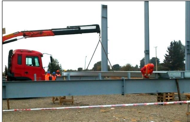
Figura 5.13. Tarea: Sujetar costanera en suspensión
