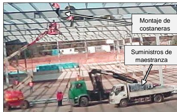
Figura 8.23. Interrupción del proceso por descarga de suministro proveniente de maestranza
