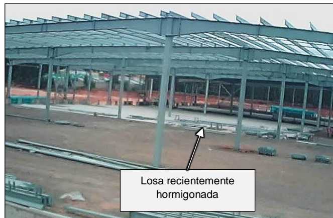
Figura 8.19. Avance de hormigonado como limitante de espacio disponible para descargas
