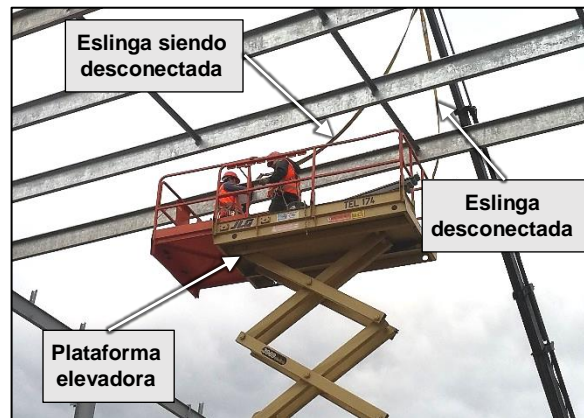
Figura 5.17. Tarea: Desconectar eslinga de carga en costanera
