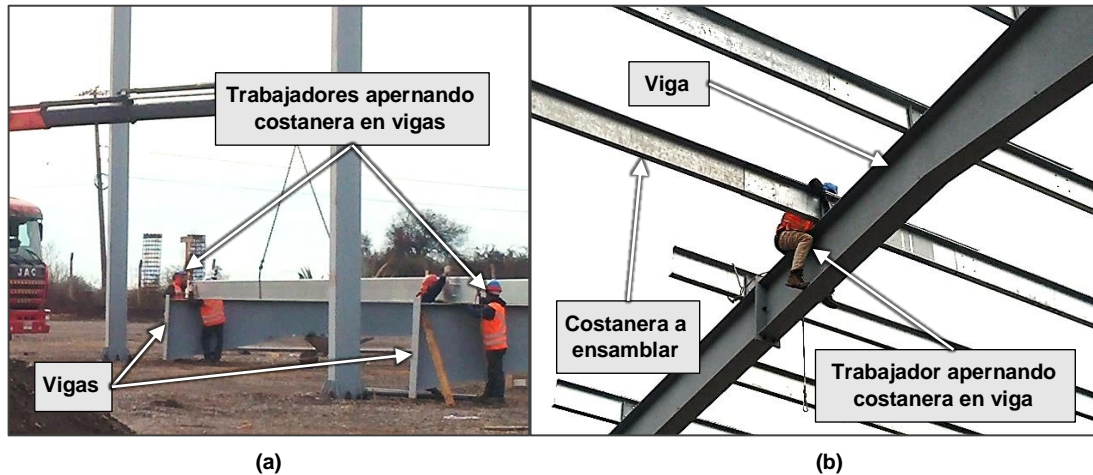
Figura 5.15. Tarea: Apernar extremo de costanera en viga
