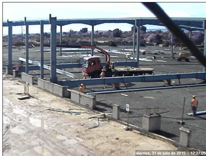
Figura 7.1. Ejemplo del registro visual obtenido mediante el sistema de observación empleado en obra
