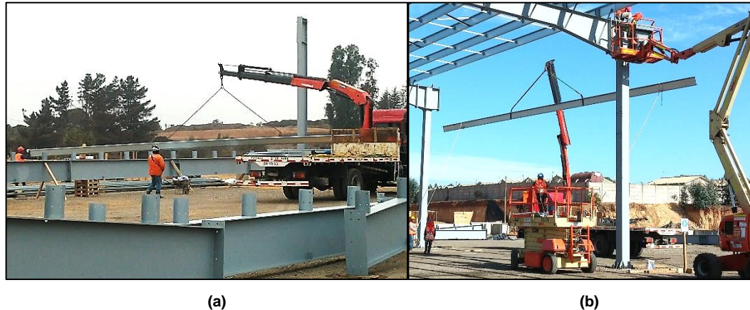
Figura 5.11. Tarea: Elevar y descargar costanera sobre par de vigas
