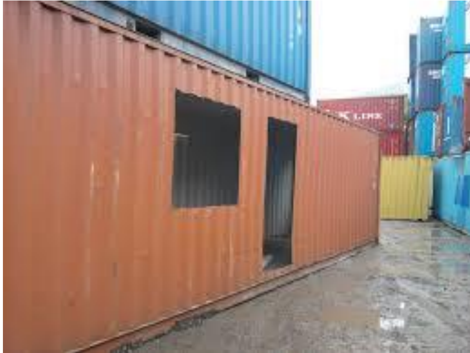
Figura 2-3: Abertura de vanos.
