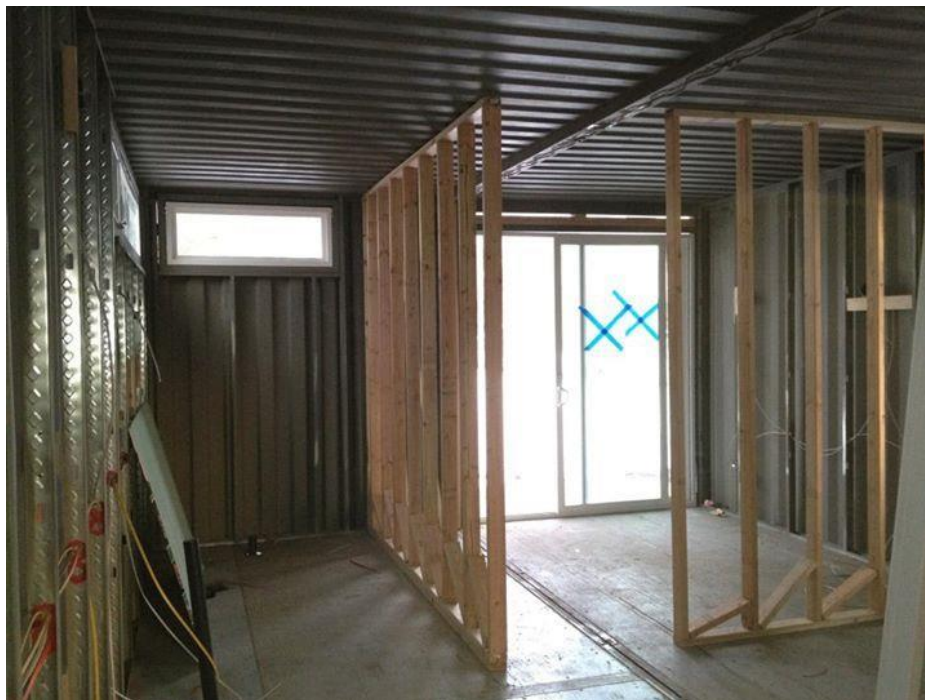
Figura 2-5: Proceso de instalación de tabiquería y ventanas.
