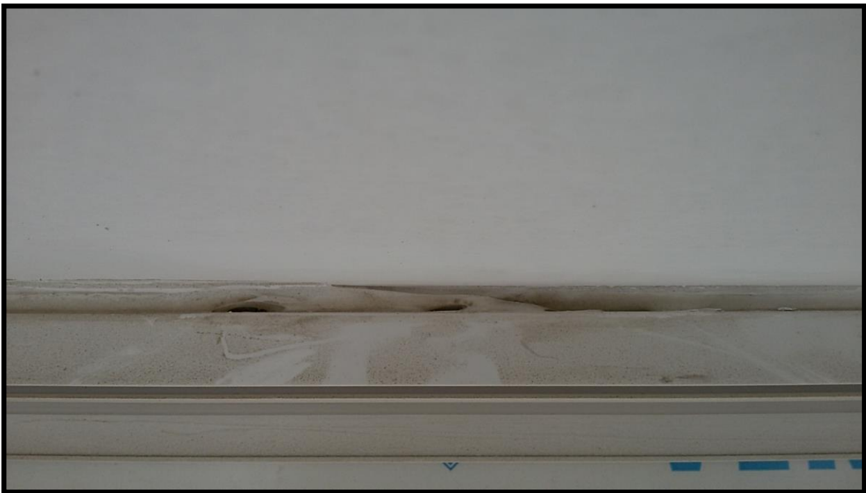
Fuente: Registro Obra Alto Lilenes
