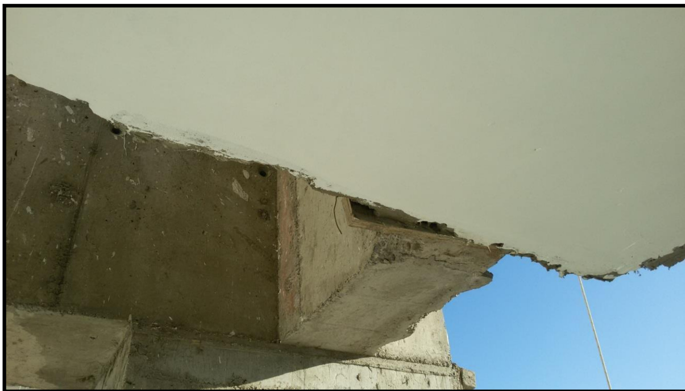
Figura 2-22. Falta fileteo en terrazas 2
