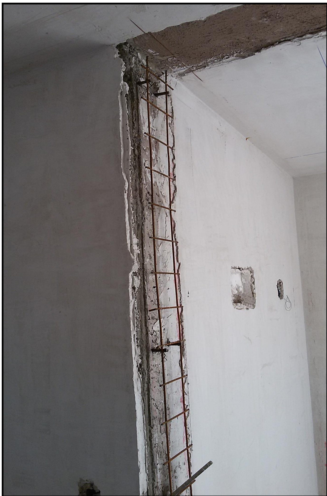
Figura 2-20. Marco de puerta, inyección de fierros
