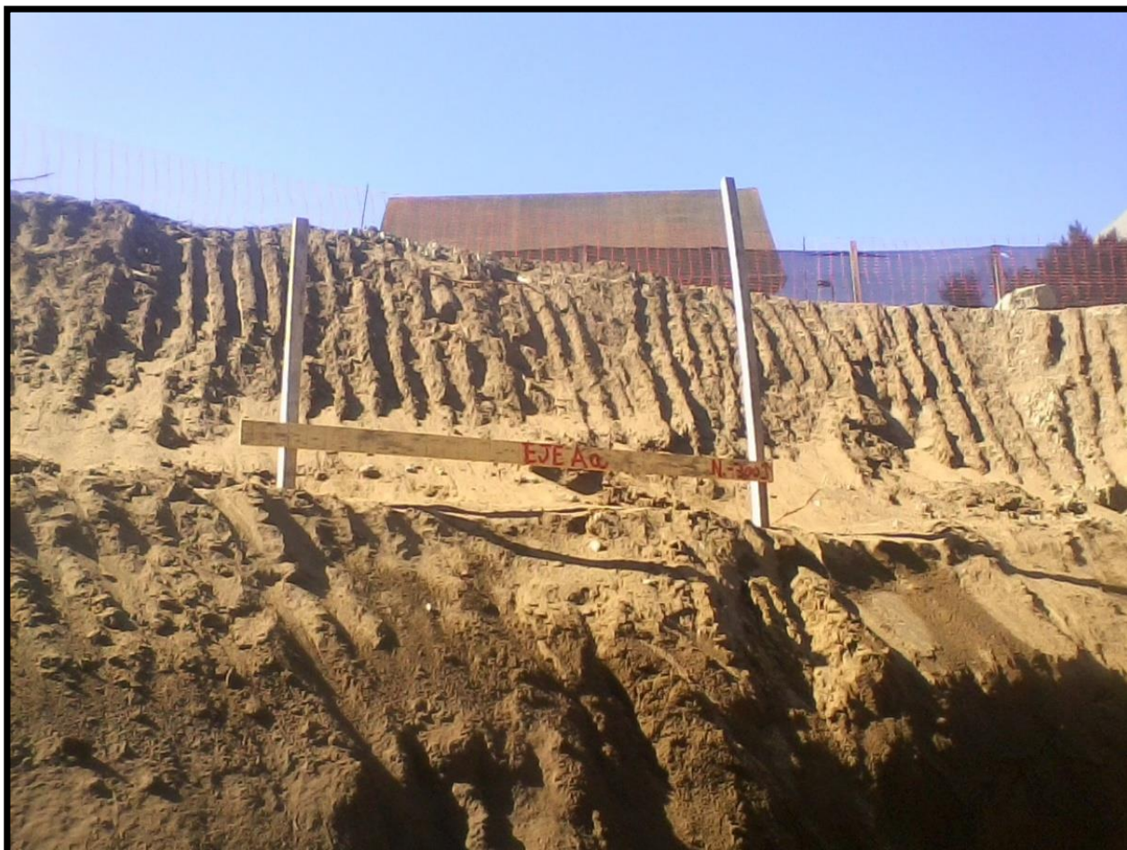
Figura 2-51. Niveletas para el desplazamiento ejes de fundaciones obra Albamar 4
