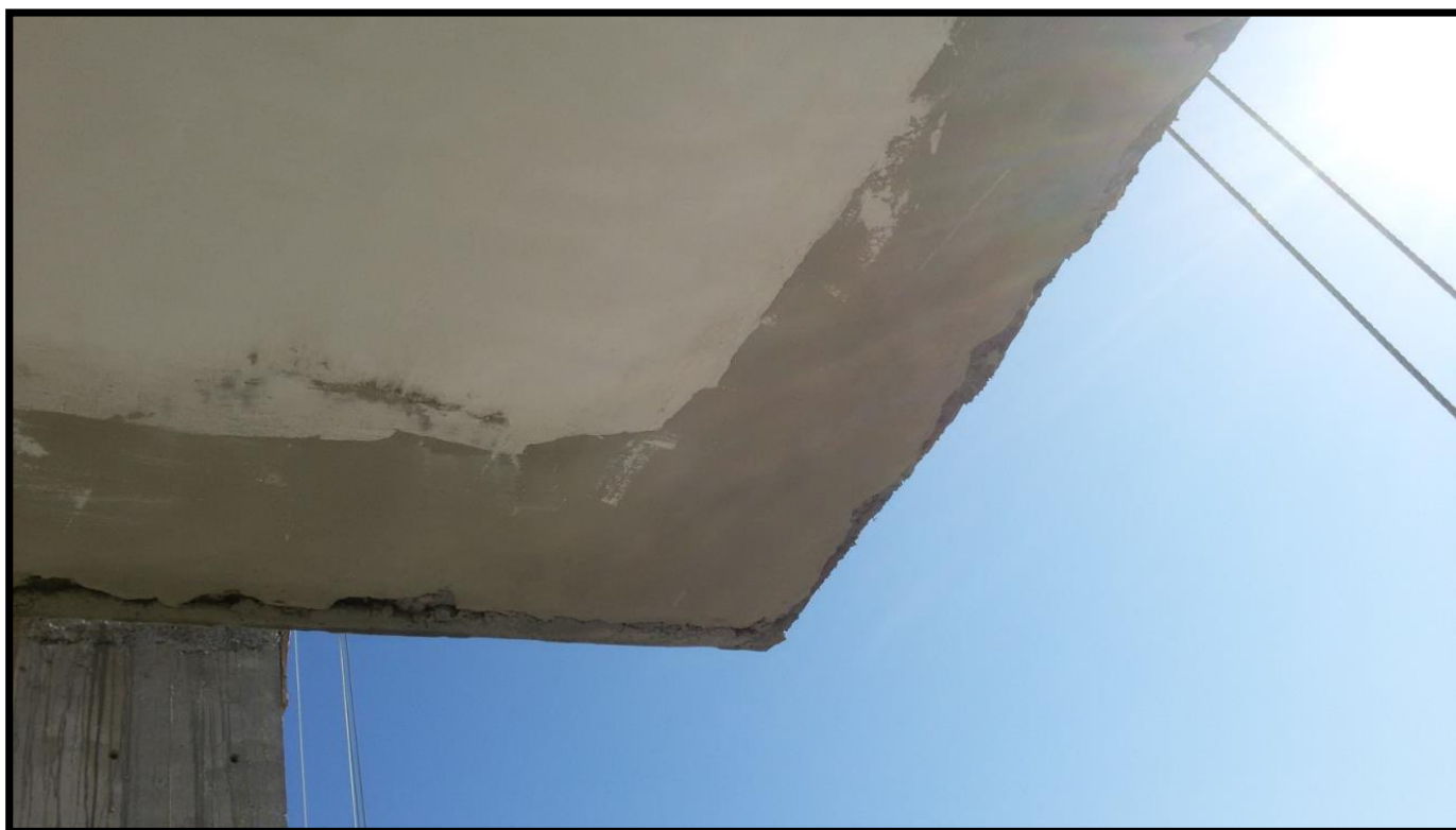
Figura 2-21. Falta fileteo en terrazas
