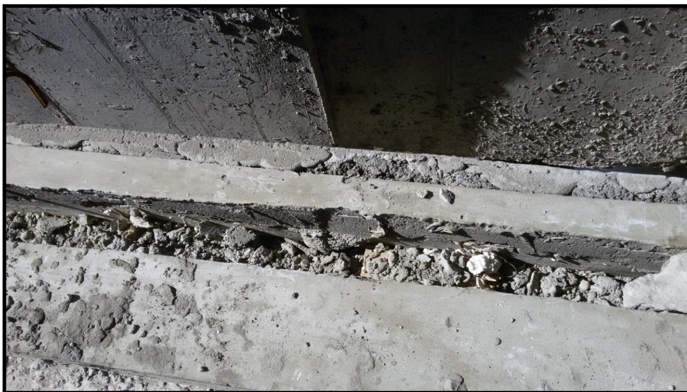
Fuente: Registro Obra Alto Lilenes Figura 2-16.Sobre carga en terrazas 2
