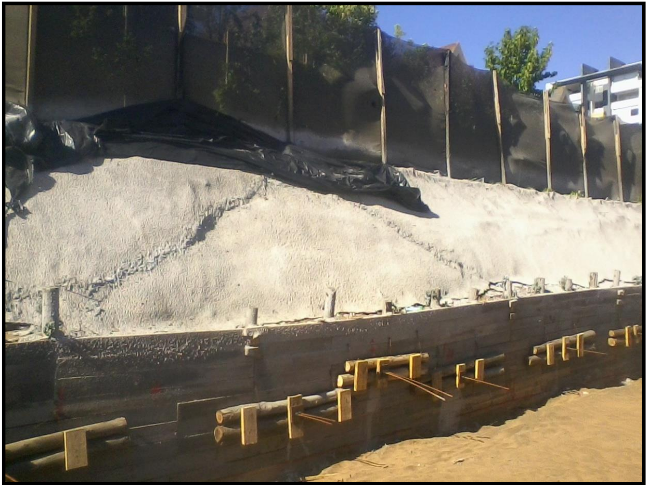
Fuente: Registro Obra Albamar Figura 2-47.Talud shotcreteado
