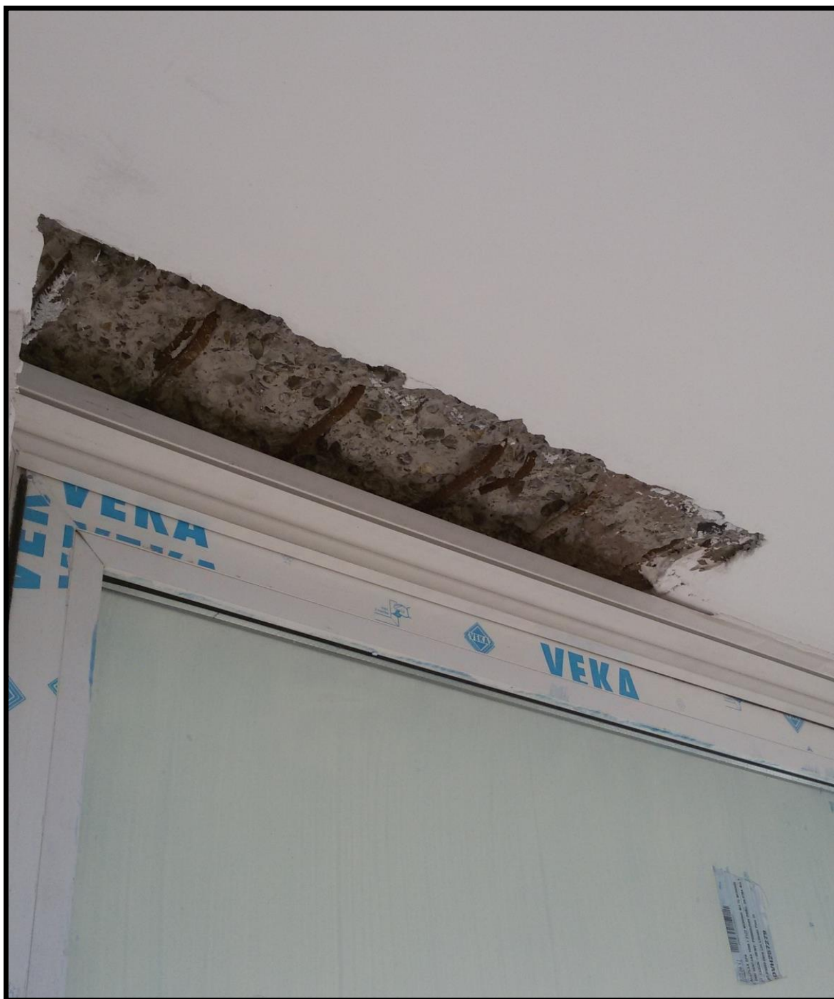
Figura 2-19. Fierro expuesto en ventanal
