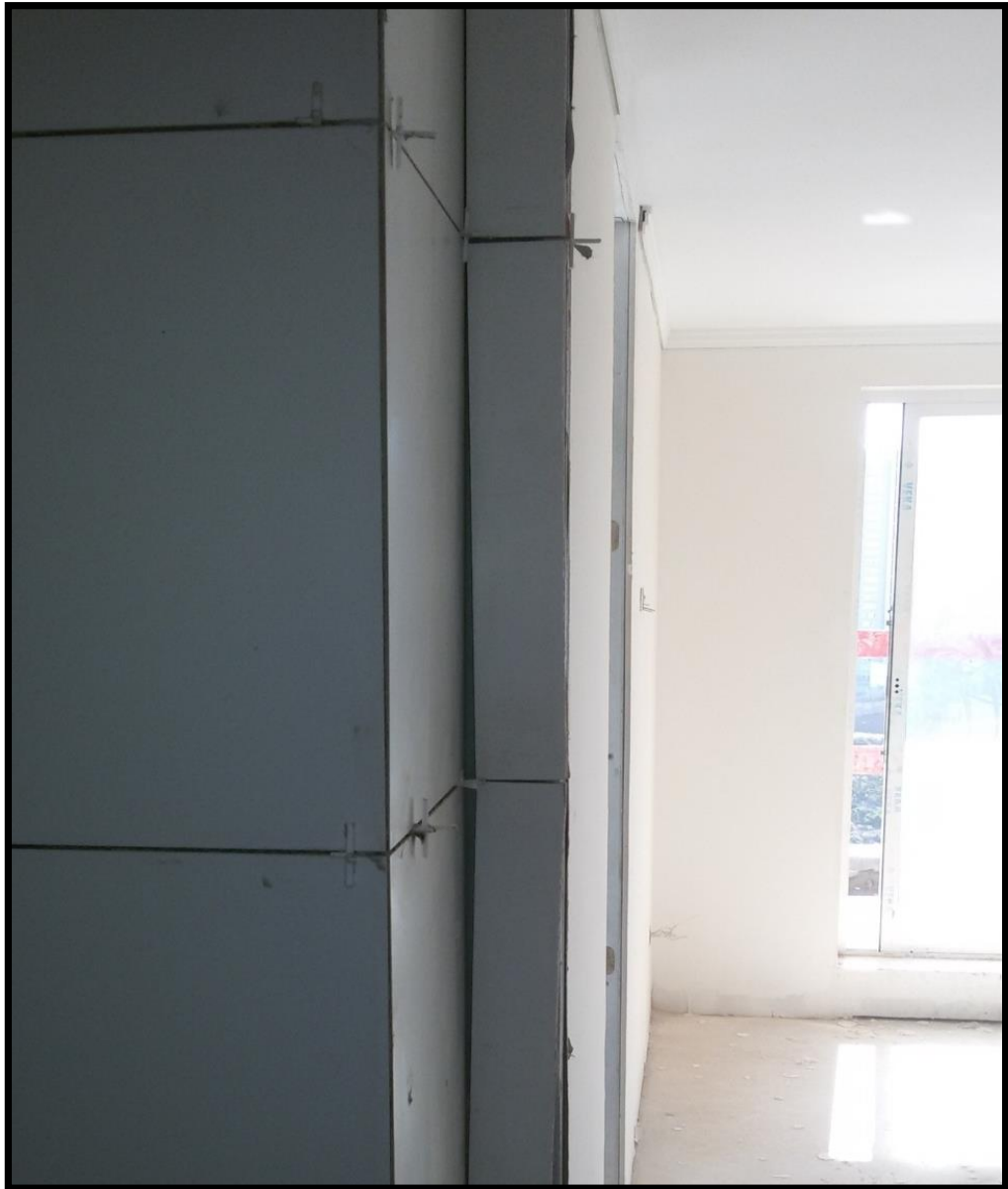
Figura 2-26. Cerámicas mal posicionadas
