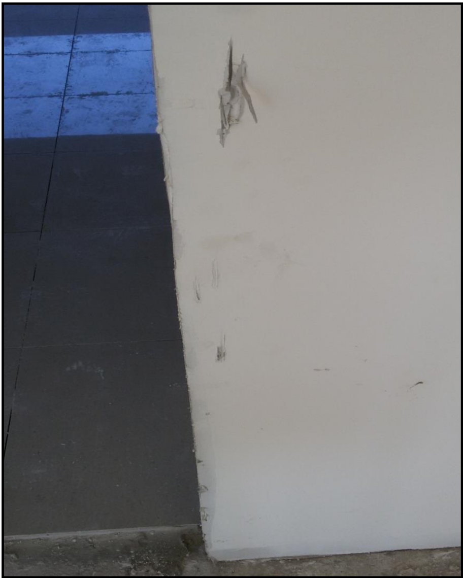
Fuente: Registro Obra Alto Lilenes
