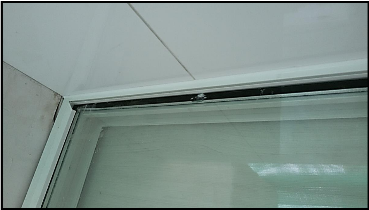
Fuente: Registro Obra Alto Lilenes
