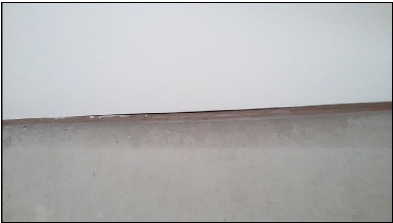
Fuente: Registro Obra Alto Lilenes
