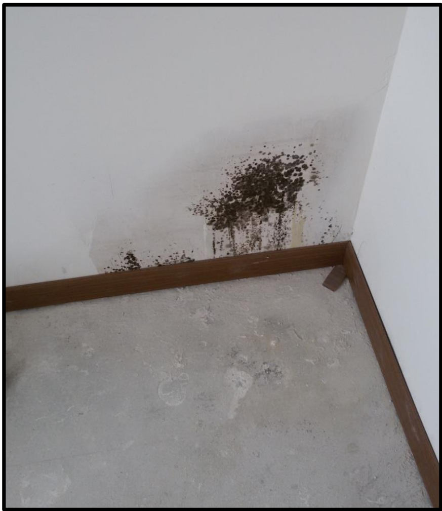
Fuente: Registro Obra Alto Lilenes
