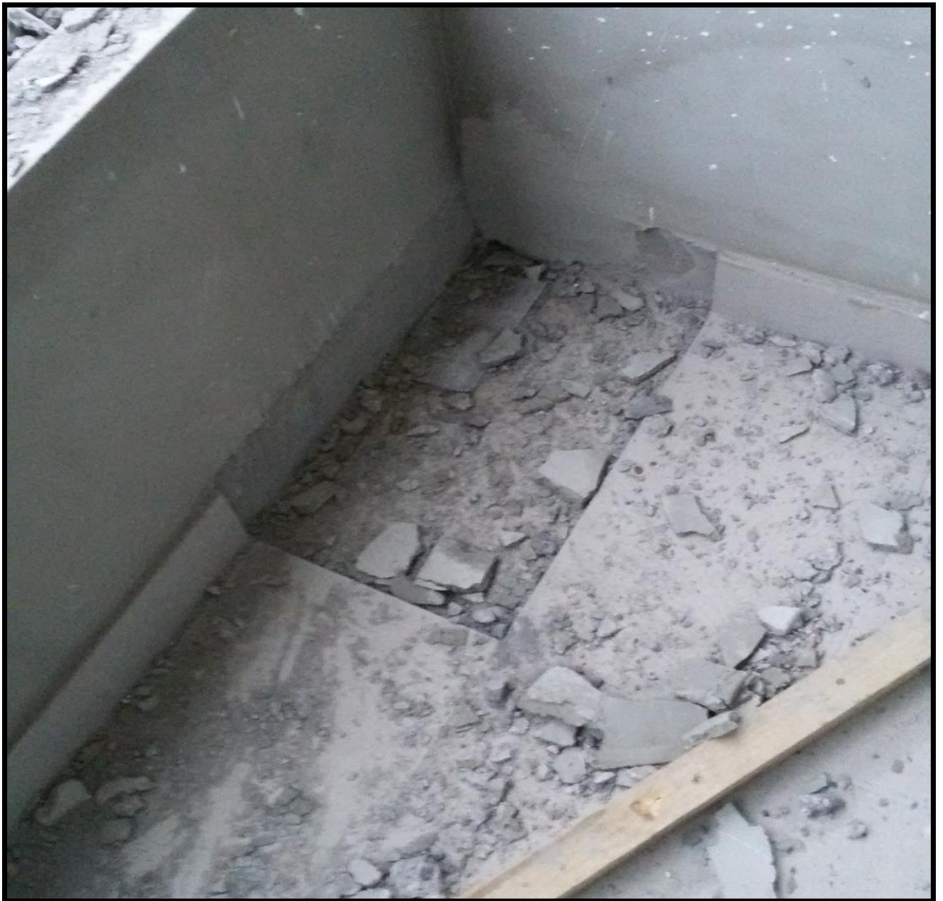
Figura 2-24. Extracción de cerámicas
