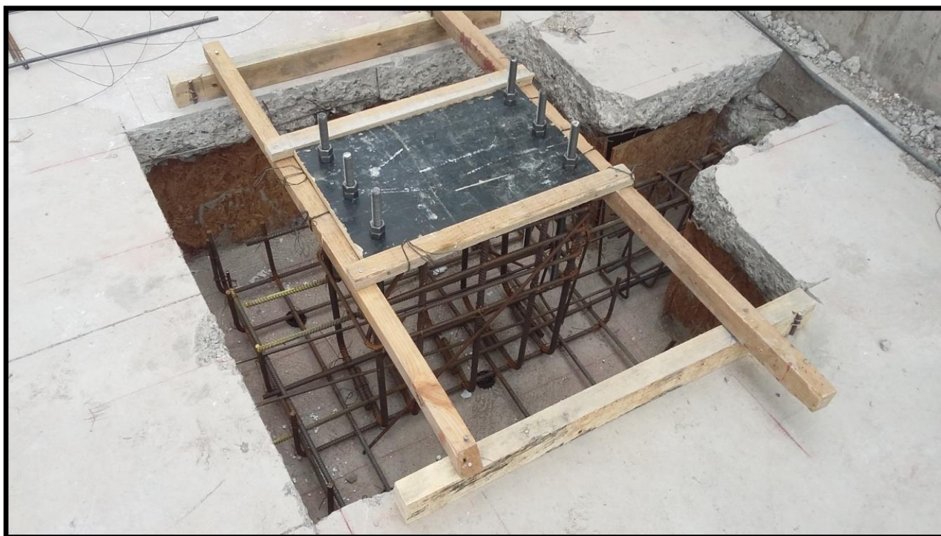
Figura 2-30. Posicionamiento de enfierradura con plantilla
