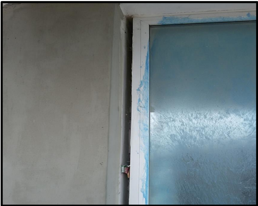
Fuente: Registro Obra Alto Lilenes
