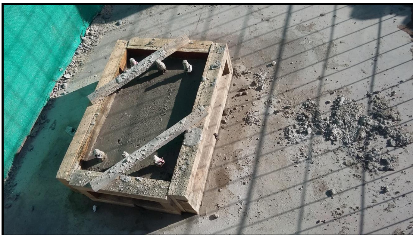
Figura 2-31. Hormigonado de dados
