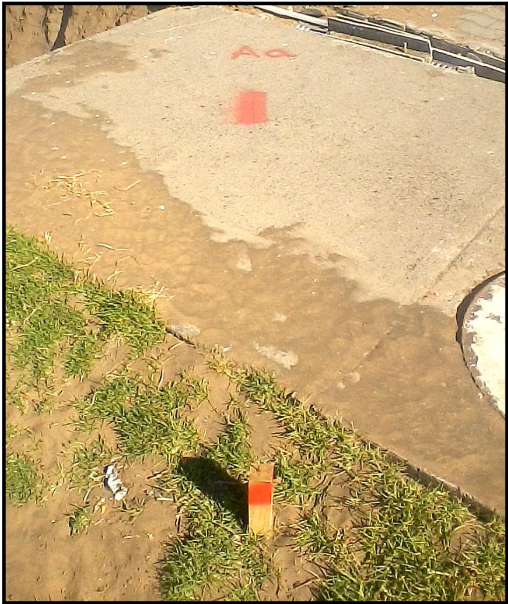
Figura 2-45.Desplazamiento ejes de fundaciones obra Albamar 1
