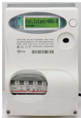
Figura 4.13: Medidor polifásico directo. Fuente [37]
