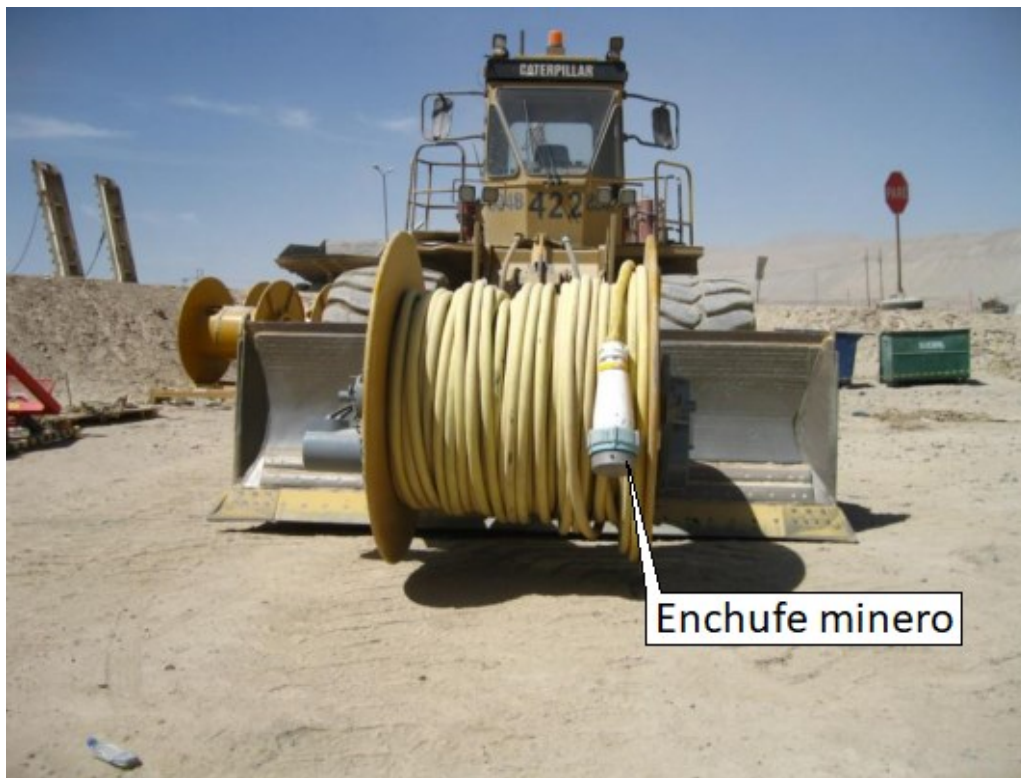
Figura 2-2: Cable trifásico de media tensión enrollado en un carretón y con un enchufe minero instalado [5].
