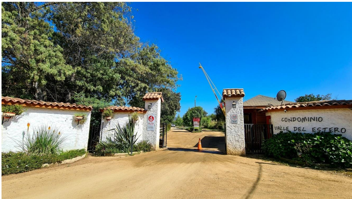
Imagen 1-1. Vista frontal del Condominio Valle del Estero. Fuente: condominiovalledelesterocl
