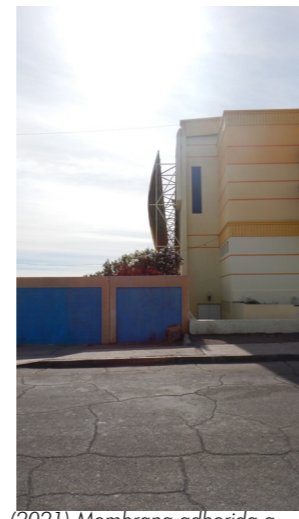
(2021) Membrana adherida a la estructura del estadio de Pica. Elaboración propia.
