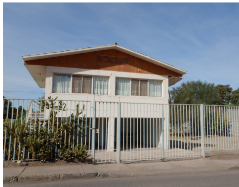
(2021) Casa contemporánea, zona urbana. Elaboración propia.
