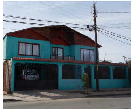
(2021) Casa contemporánea, zona urbana. Elaboración propia.
