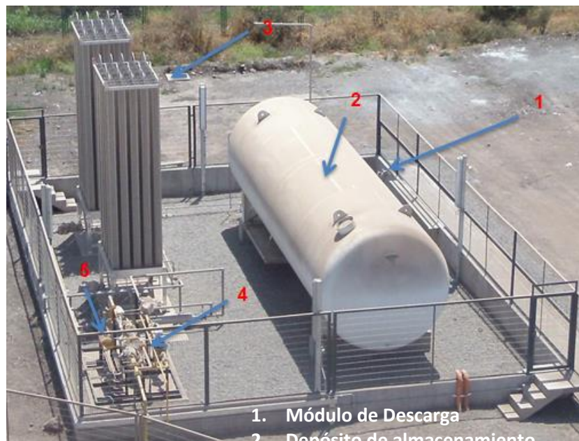
Figura 6-8: Principales componentes de una PSR. Fuente: http://www.metrogas.cl/
