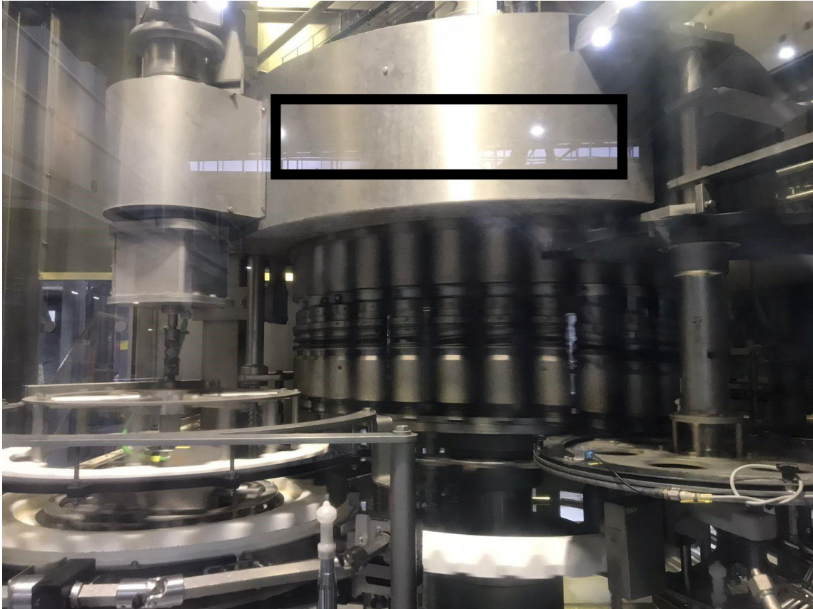
Figura 3-6 mejora de inspección 5
