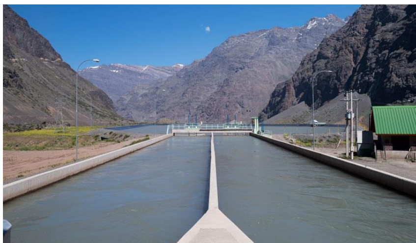
Ilustración 12. Desarenador 1 y 2 en bocatoma Hornitos.
