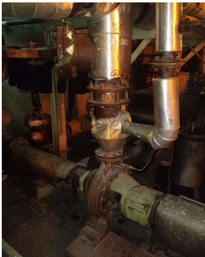
Figura 1- 20: bomba centrífuga en estudio.
