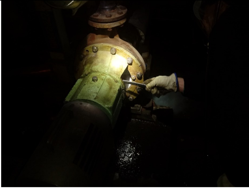
Figura 4- 8: Reapriete de prensa estopa durante una inspección visual al equipo.
