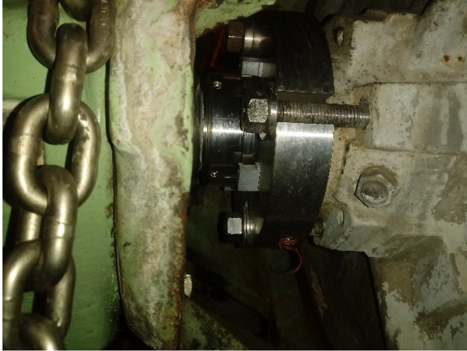
Figura 2- 13: sello mecánico montado en bomba sulzer app3.
