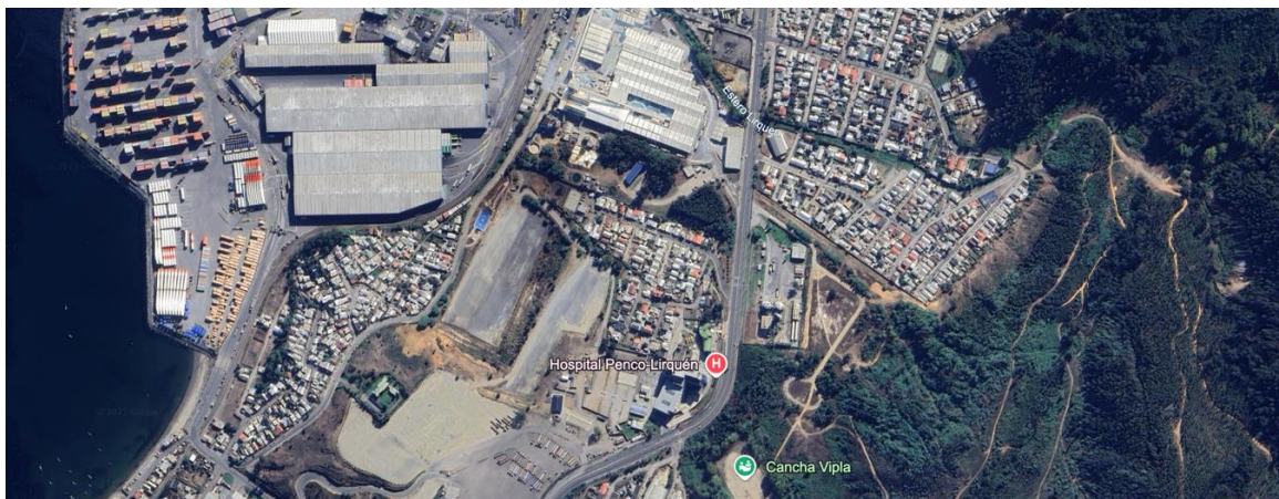
Figura 1-3 Vista satelital del hospital Penco-Lirquén
