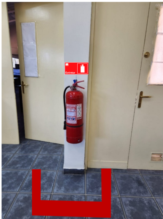
Imagen 4- 12 Zona de extintor demarcada y señalizada. Fuente. Imagen creada a partir de Figura 4-8, Figura 4-9 y Figura 4-10
