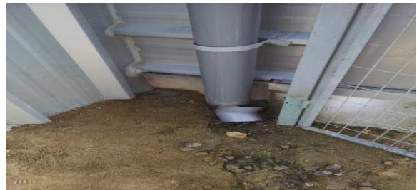
Figura 2.2 Canal de aguas lluvias
