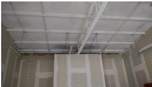
Figura 2.1 Eliminación de tabique no estructural
