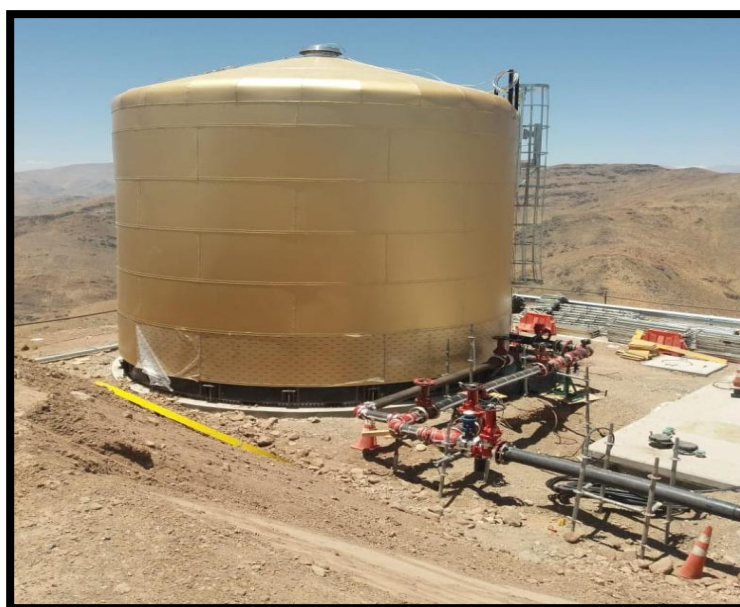
Figura 0-4 Estanque de almacenamiento de agua gris en Minera Centinela
