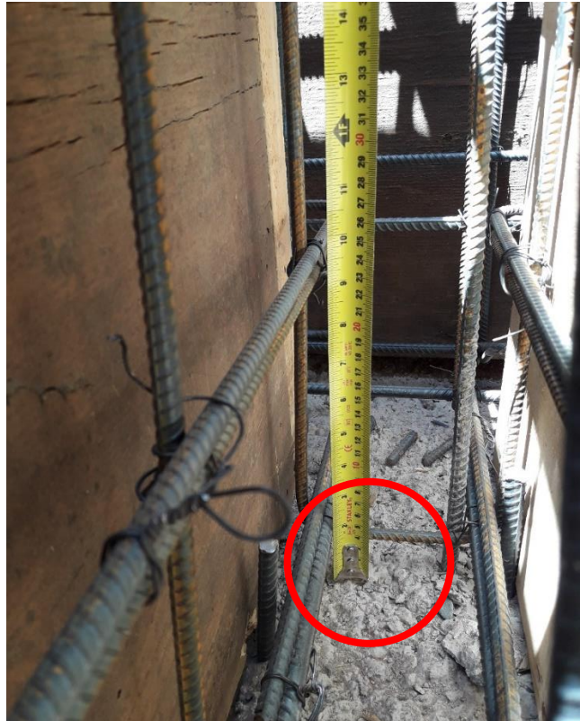
Figura 2.3: Verificación de distancia entre enfierradura y cimiento
