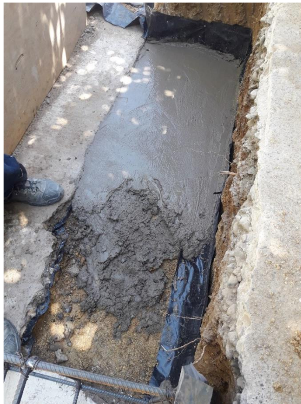
Figura 2.7: Ausencia de polietileno en emplantillado
