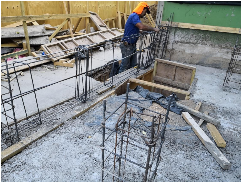
Figura 2.9: Reconstrucción de enfierradura de sobrecimiento
