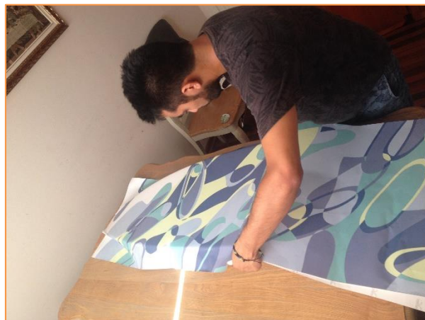
Imagen 3.10.4 Instalación de material pvc con el uso de espátula
