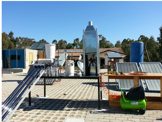
Figura 3.19: Sistema en etapa implementación
