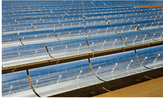
Figura 2.8: Colector cilíndrico parabólico
