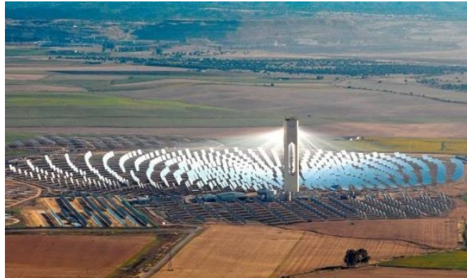
Figura 2.11: Colector de campo de helióstato
