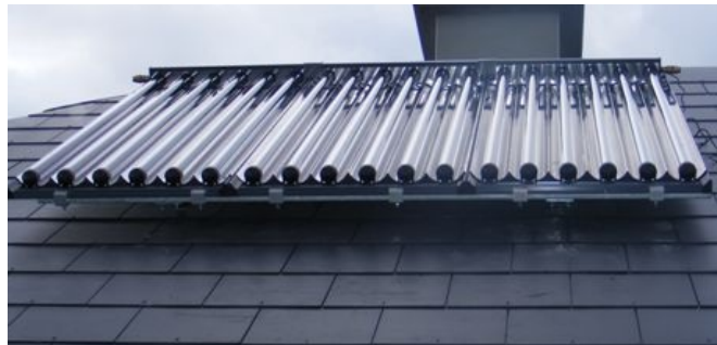
Figura 2.7: Colectores parabólicos compuestos
