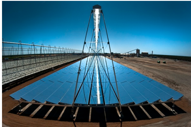
Figura 2.9: Reflector de Fresnel lineal
